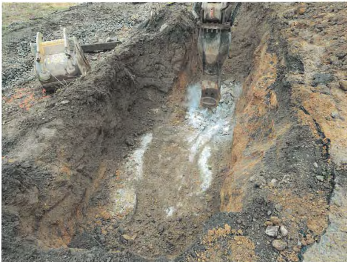
Skalní výchozy v místě drenážní šachty, (pohled po směru staničení)
