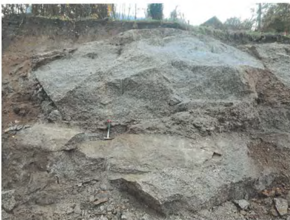
Pohled na jižní stěnu výkopu
