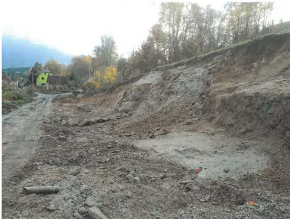
Skalní výchozy v prostoru SO 264, (pohled po směru staničení)
