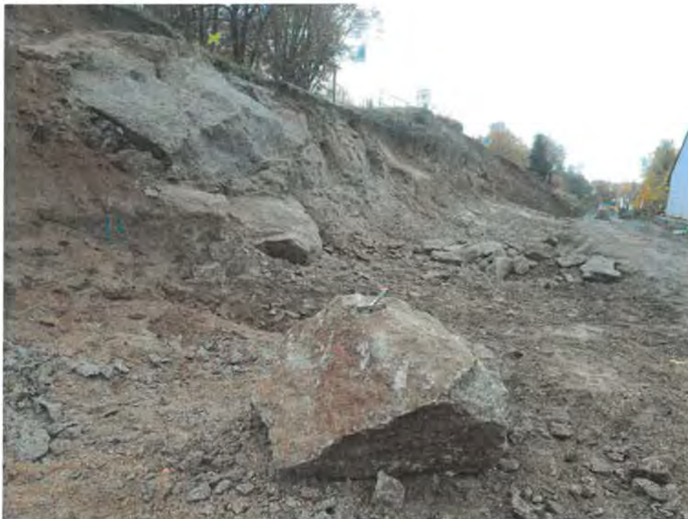
Vytěžený blok po rozpojení skalního masivu bouracím kladivem
