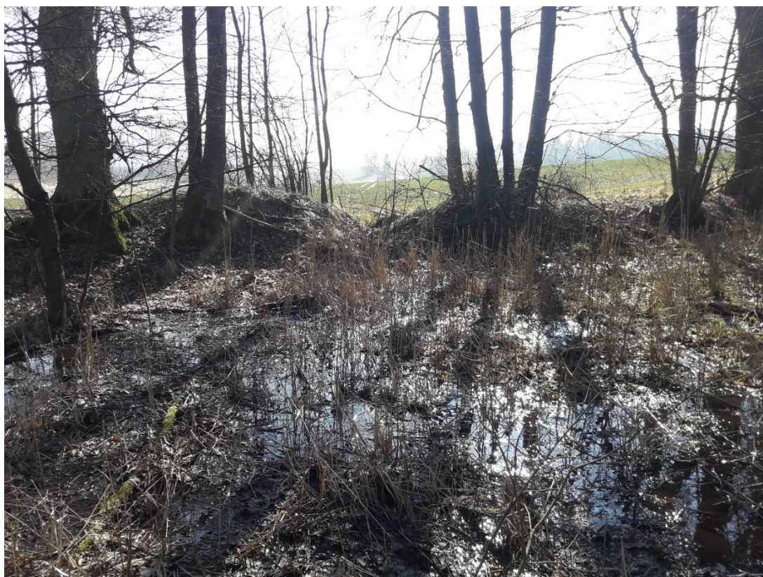
Obrázek 6_Pohled k návodnímu líci hráze
