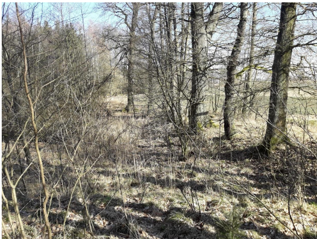
Obrázek 3_Návodní líc původní hráze
