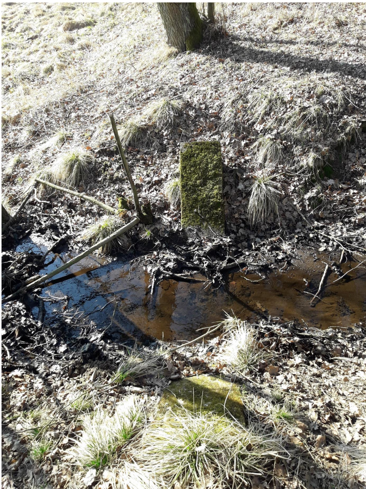
Obrázek 2_ Stávající stabilizační práh
