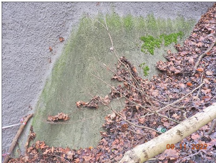
Pravé křídlo OP2.
