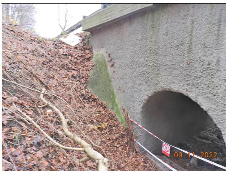
Pravé křídlo OP1.
