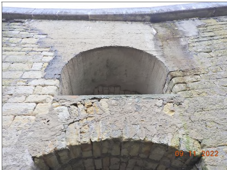
Levá čelní zeď.
