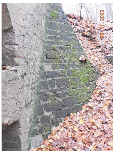
Pravé křídlo OP2.
