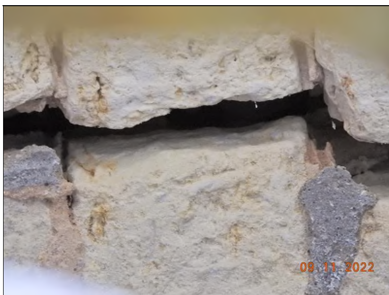
Závažné rozevření spáry v horním patře vlevo.
