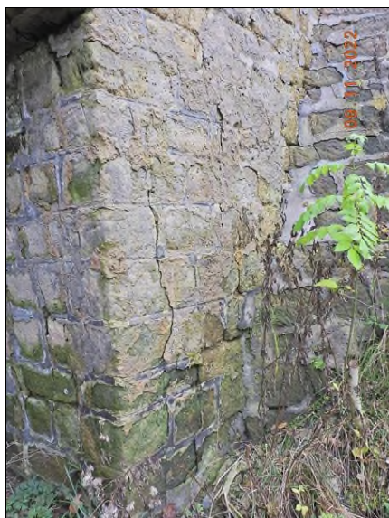
Levé křídlo OP1.
