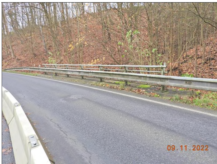
Pravá strana mostu.
