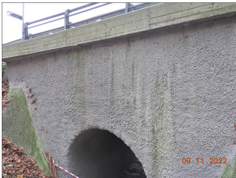
Pravá čelní zeď.
