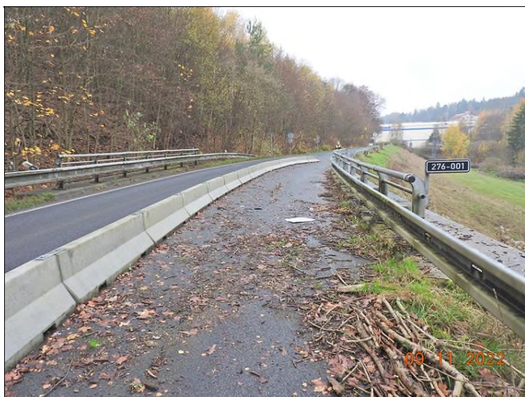
Šířkové uspořádání na mostě, pohled proti směru staničení.
