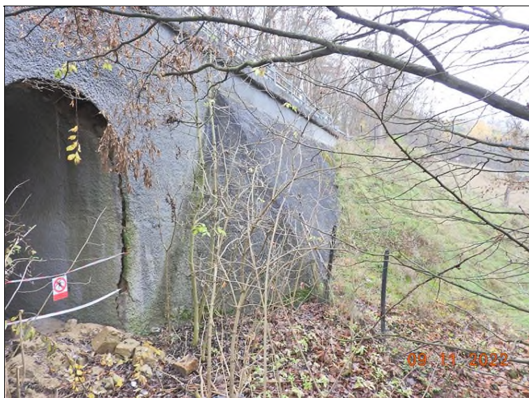
Levé křídlo OP1.
