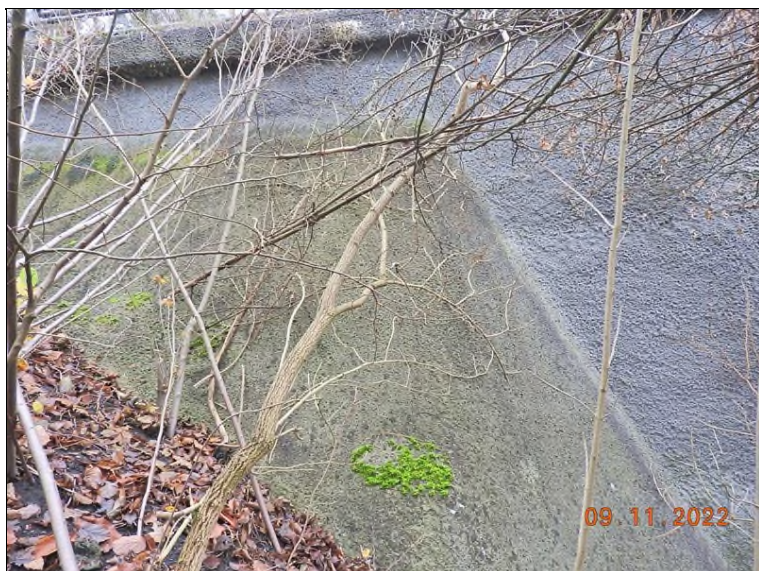
Levé křídlo OP2.
