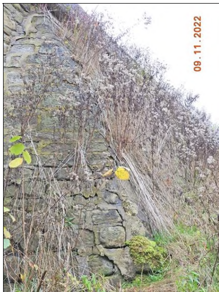
Levé křídlo OP1.
