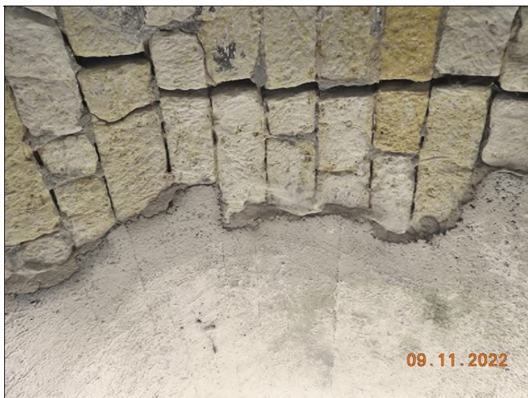
Závažné rozevření spáry v horním patře vlevo.
