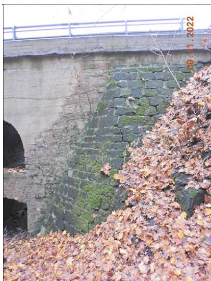
Pravé křídlo OP2.
