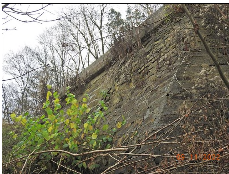
Levé křídlo OP2.
