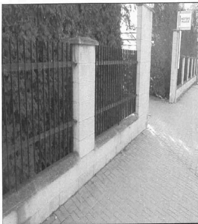
Fotografie - stávající stav
