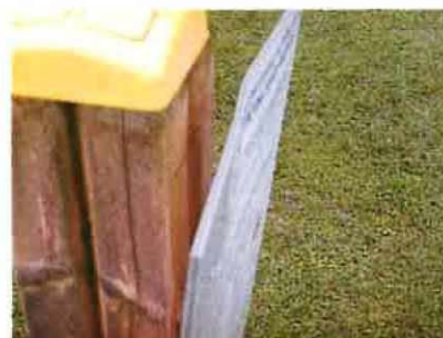
Přišroubování řádu ke sloupku + Repasování povrchu sloupku
