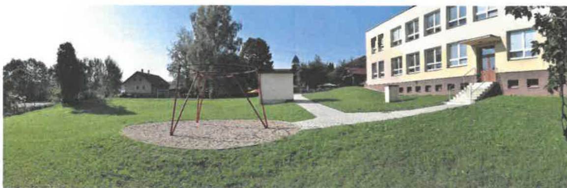
Foto stávajícího stavu
