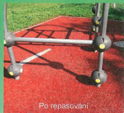
Ukázky repasovaného povrchu Softnyx (po 7 letech užívání)
