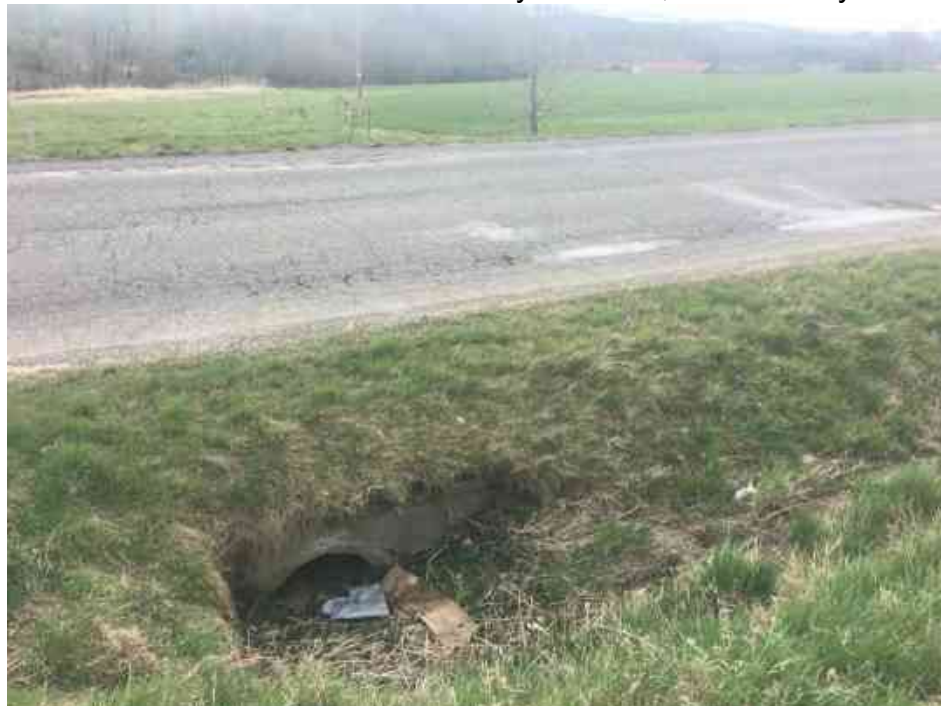
Obr. 3 Propustek 06 – pohled na vtok
