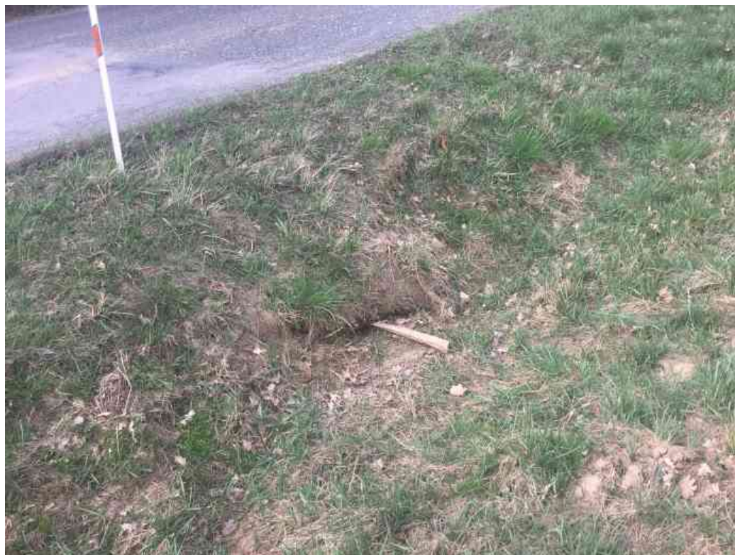
Obr.6 Propustek 10 – pohled na „vtok“
