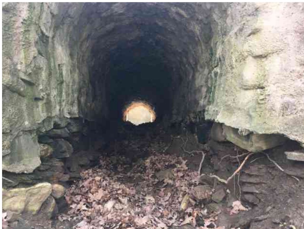
Obr. 1 Propustek 01 – pohled od severu na jih
