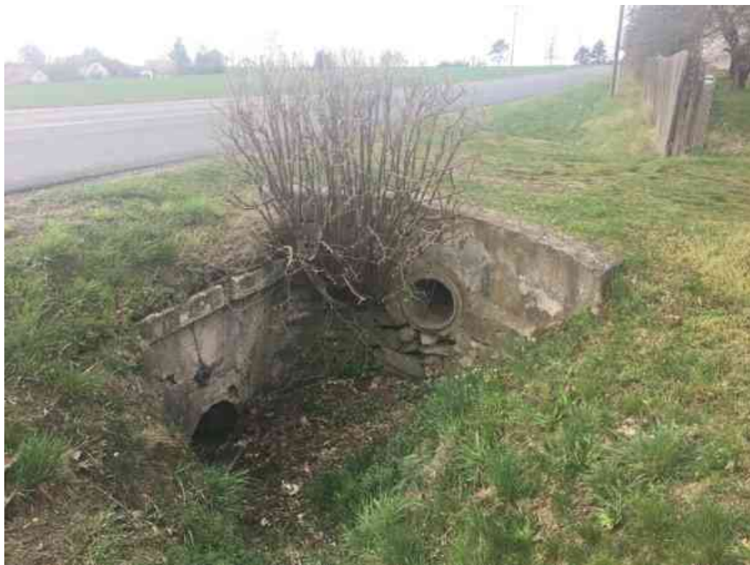
Obr. 4 Propustek 08 – pohled na vtok
