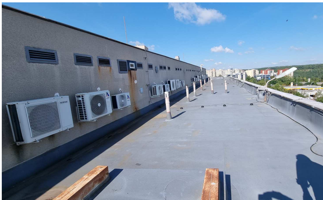
Obr. č.4. Pohled na stávající střechu objektu - 5.NP; změna/dostavba oproti původní PD – 1973
