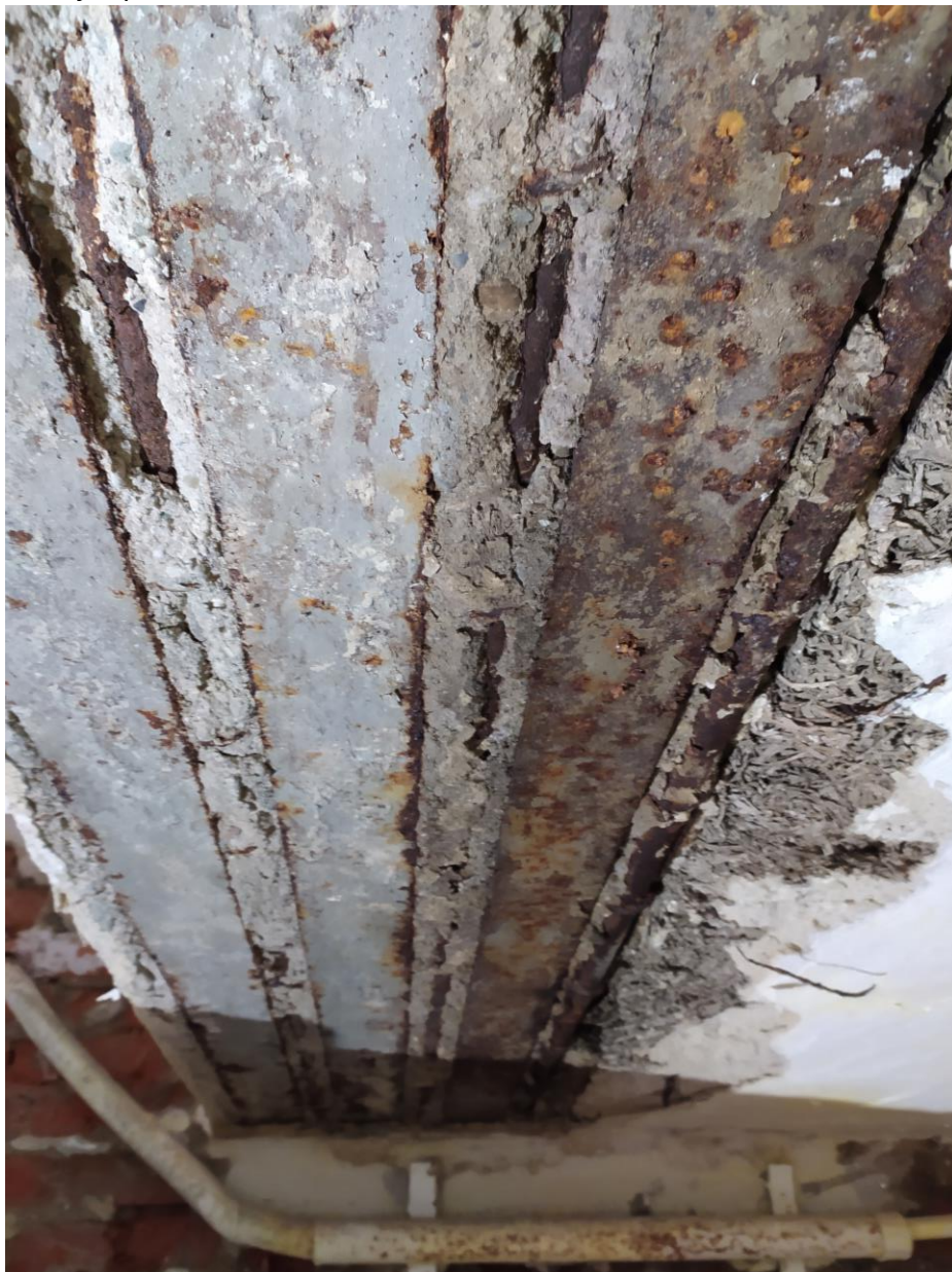
Stávající průvlak v šatně dorostu
