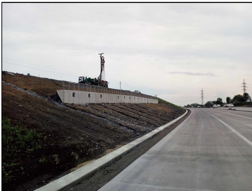
Obrázek 3 Pohled na zárubní zeď sanující sesuv v km 31,220-31,250 z doby výstavby (06/2019)
