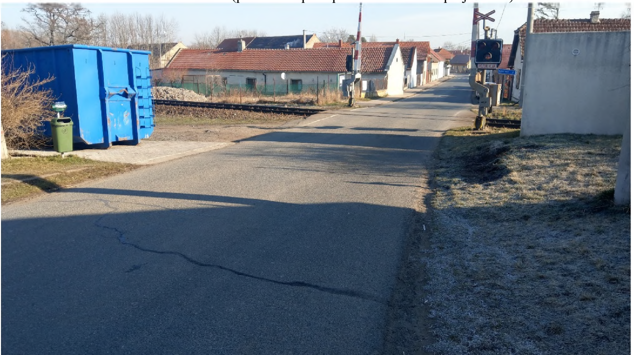
Konec úseku (pracovní spára před železničním přejezdem)
