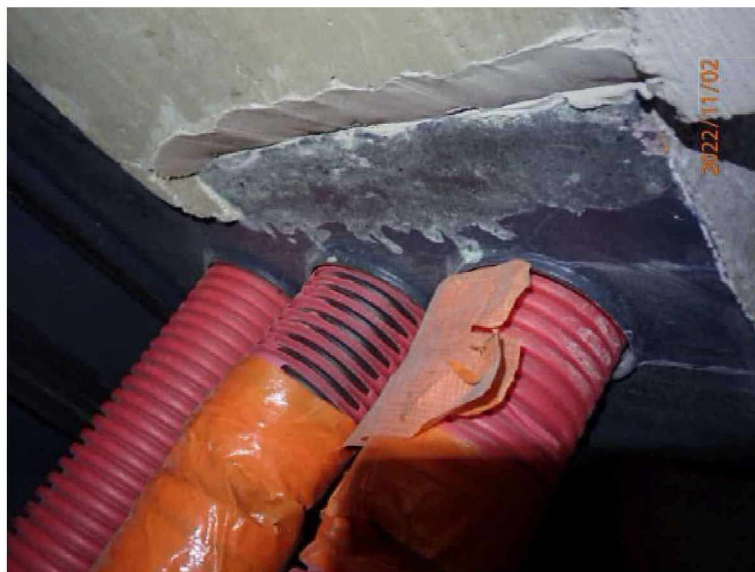
Detail sanace okraje betonu u chrániček ve vnitřní římse
