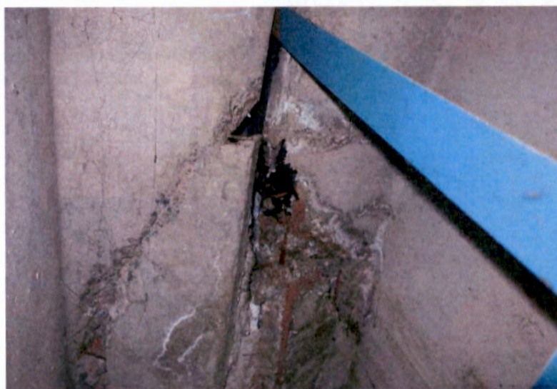
DTTO – v oblasti dilatační spáry je zakotvené vedení vzduchotechniky
