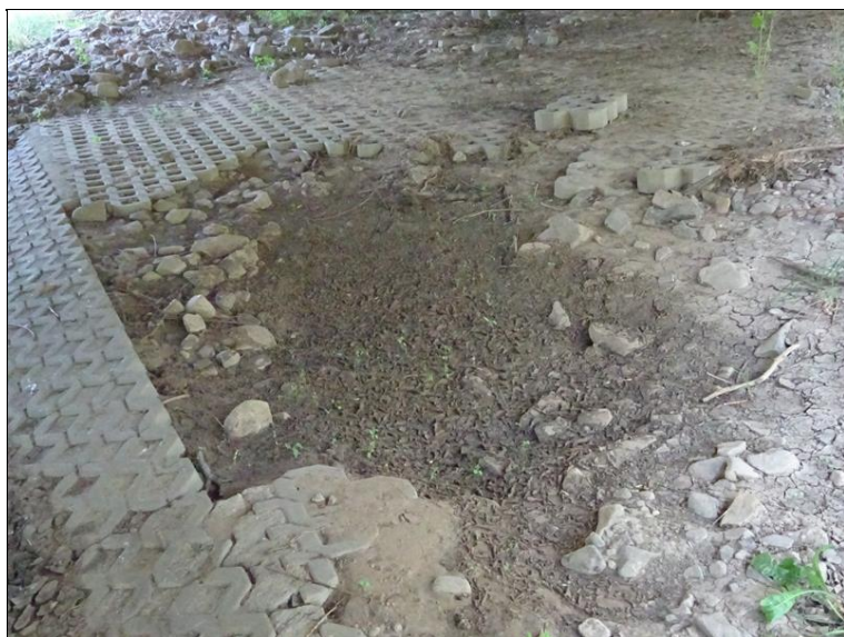
60_rozebrane odlazeni pod mostem.JPG
