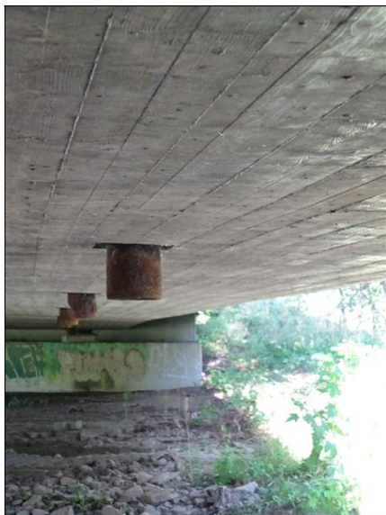
45_koroze odvodnovacu.JPG
