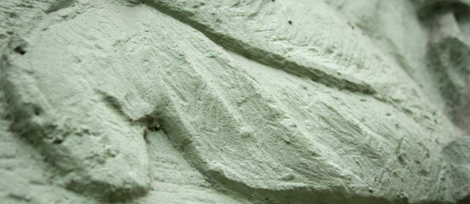
Pohled na detail celoplošného nátěru kamene
