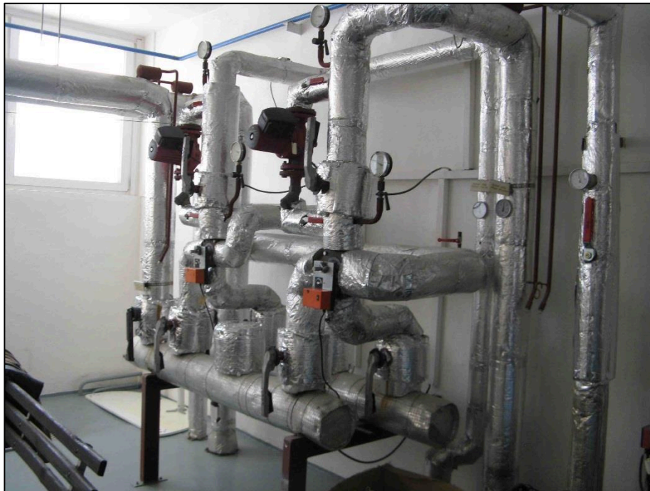
Obr.č. 9 Pohled na čerpadlovou skupinu TV s rozdělovačem a sběračem
