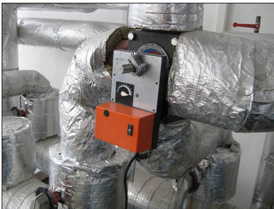
Obr.č. 10 Pohled na čtyřcestný ventil DUOMIX se servomotorem BELIMO SM 220
