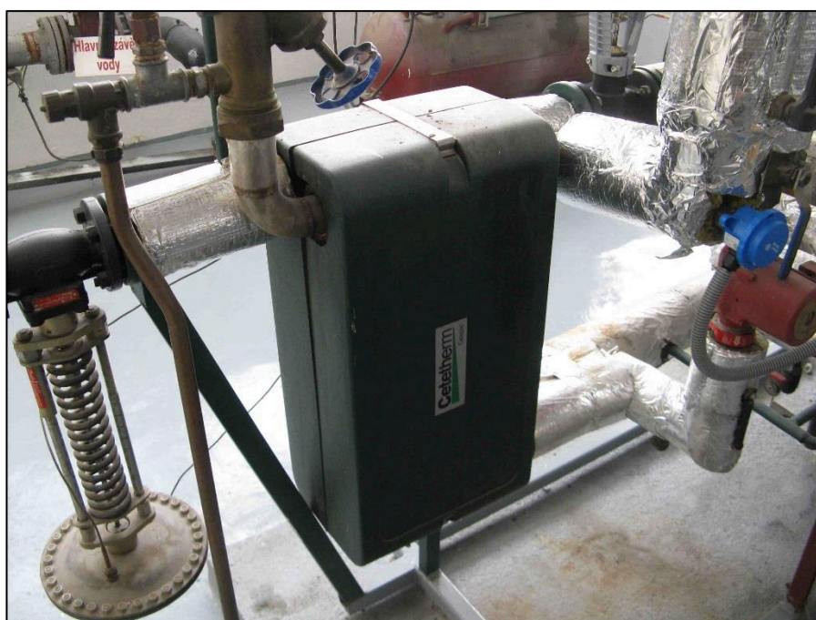
Obr.č. 4 Deskový výměník TV CETETHERM a regulační ventil
