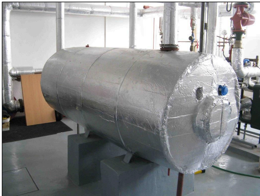
Obr.č. 13 Pohled na zásobníkový ohřivač TUV DRUKOV o objemu 1.000 l
