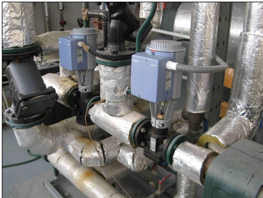
Obr.č. 5 Regulační ventily VVF 52/25-5, DN 25, PN 25 s pohonem Siemens SKD 62
