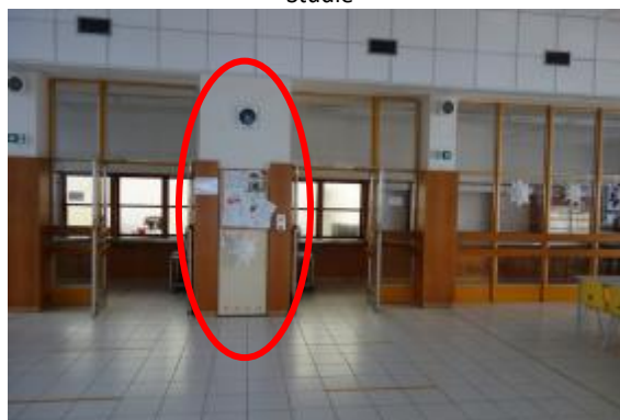
Obrázek 31 – Pohled z jídelny – bude odstraněno obložení a dále budou odstraněny skleněné stěny, označený sloup se bude odstraňovat.
