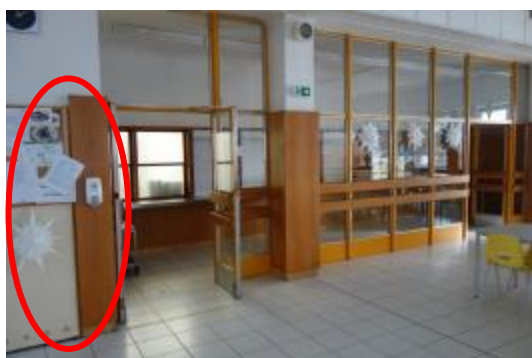
Obrázek 32 – Pohled z jídelny – bude odstraněno obložení a dále budou odstraněny skleněné stěny, označený sloup se bude odstraňovat.
