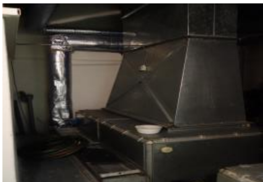
Obrázek 40 – Stávající prostory strojovny vzduchotechniky, viz. Studie, bude případně měněno/ rekonstruováno v rámci nezbytných vyvalých přímo souvisejících úprav
