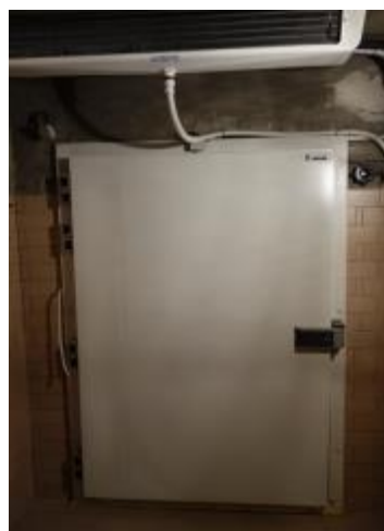
Obrázek 4 – Vstupní dveře do mrazícího boxu, výměna dveří
