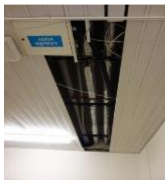
Obrázek 2 – Vstup do kuchyně, chodba – rozvody v podhledu, detail.
