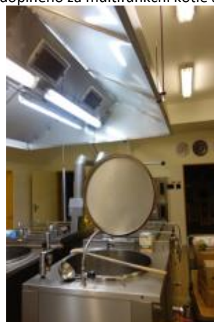
Obrázek 11 – Stávající digestoř nad kotli o objemu 200l, bude se měnit dle Studie
