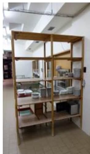
Obrázek 29 – Výdej obědů číslo 2 a 3 – bude provedena modernizace výdeje, vč. odstranění dřevěného obložení dle Studie
