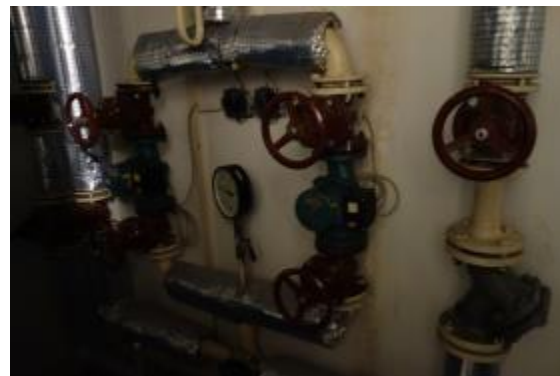
Obrázek 41 – Stávající prostory strojovny vzduchotechniky, viz. Studie, bude případně měněno/ rekonstruováno v rámci nezbytných vyvalých přímo souvisejících úprav
