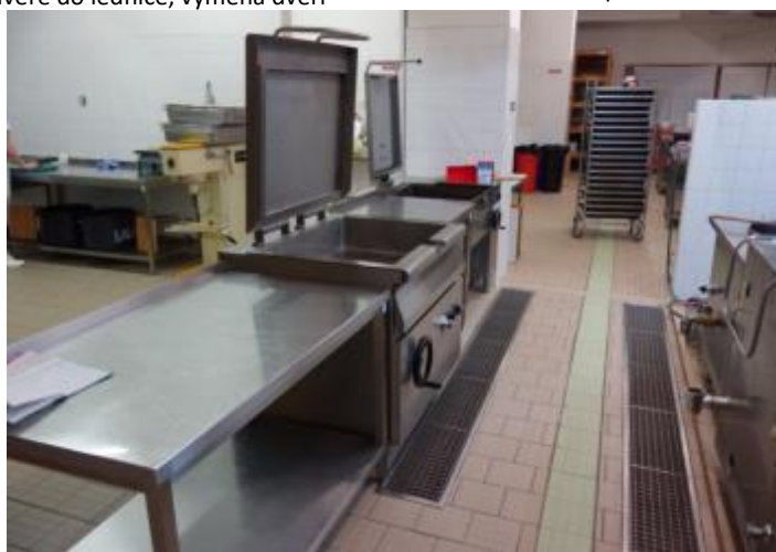
Obrázek 5 – Pohledy do kuchyně – elektrické pánve, budou měněny vč. jejich dispozice dle Studie za multifunkční pánve
