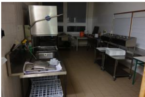
Obrázek 22 – Prostor sběru a mytí nádobí – prostor pro mycí linku a sběrný pás pro myčku stolního nádobí. Výměny myček za mycí centrum stolního nádobí dle Studie
