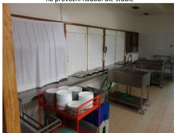
Obrázek 27 – Výdej obědů číslo 1 – bude provedena modernizace výdeje, vč. odstranění dřevěného obložení dle Studie
