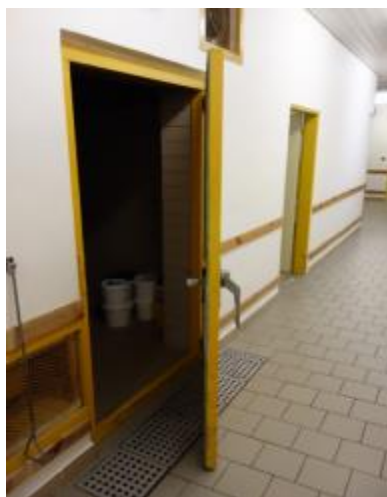
Obrázek 3 – Vstupní dveře do lednice, výměna dveří
