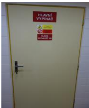
Obrázek 34 – Elektrické vedení – Hlavní vypínač elektrické energie, pohled na vstup
