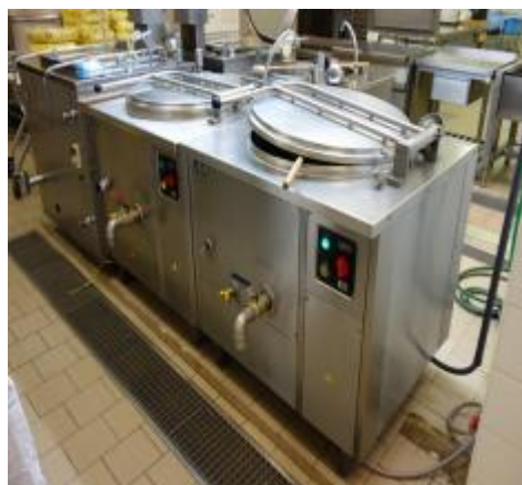
Obrázek 7 – Pohledy do kuchyně – elektrické kotle 200l budou měněny vč. dispozice dle Studie
