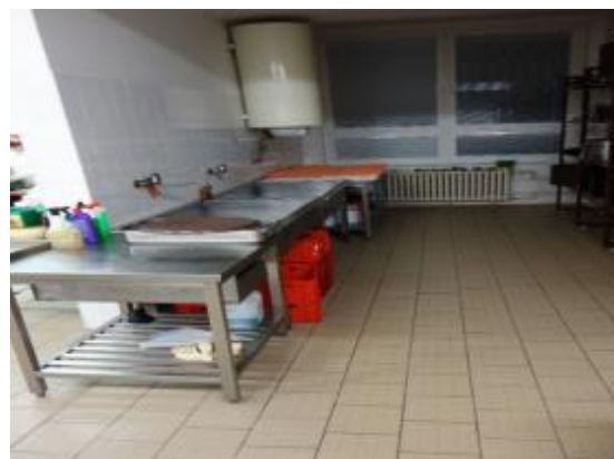
Obrázek 25 – Prostor pro mycí zařízení provozního nádobí – mycí a oplachovací dřez, budou kompletně vyměněny za myčku na provozní nádobí dle studie
