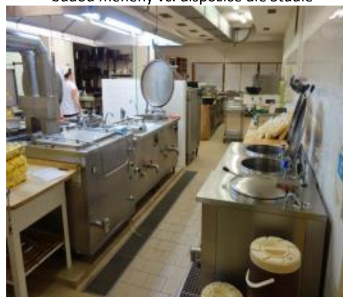
Obrázek 9 – Pohledy do kuchyně – spotřebiče budou vyměněny a dispozice pozměněna dle dokumentace, elektrické kotle 80l budou měněny dle studie za nové, dále bude doplněno za multifunkční kotle a pánve
