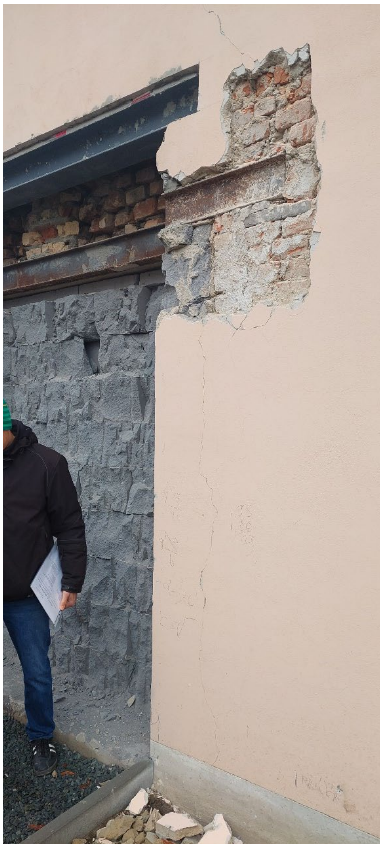
Sonda k zjištění stavu ostění
