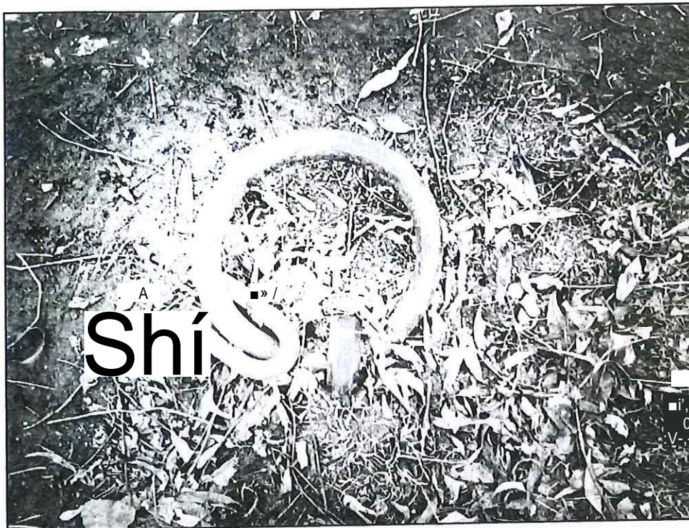
Obr. 11 - vázací kruh v betonovém bločku v terénu
