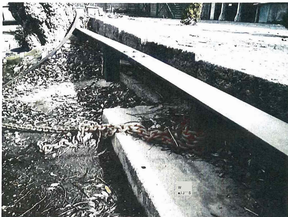
Obr. 13 - L profil zaberaněný k zakotveným kolejnicím
