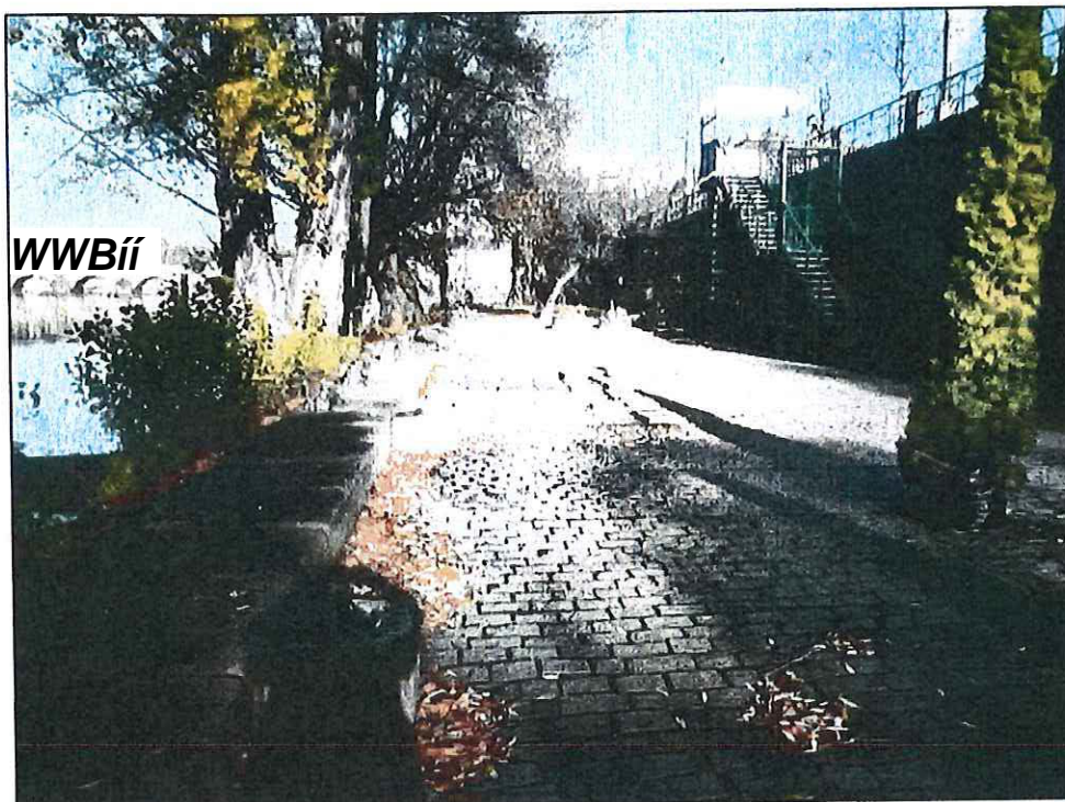
Obr. 1 - Celkový pohled na náplavku
