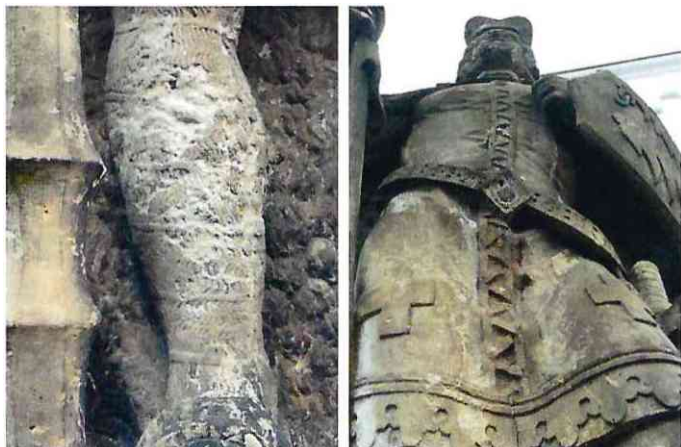
Foto 2, 3 Socha je pokryta biologickými činiteli a silně fixovanými prachovými depozity. Degradace originálu především ve srážkových stínech a v méně kvalitních partiích pískovce.
