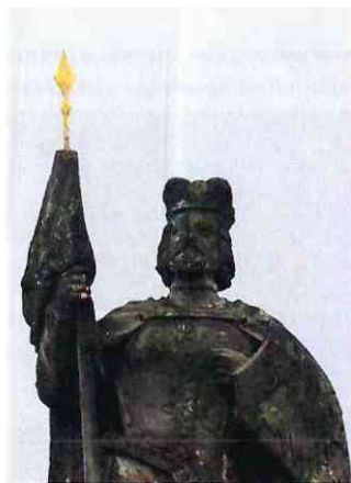
Foto 6 Vrchní část kopí neodpovídá původnímu řešení, proto bude rekonstruována v přírodním kameni a kované špičce. Stejně lak bude vykován i chybějící křížek na knížecí čapce.
