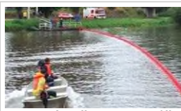
norná stěna na vodě
