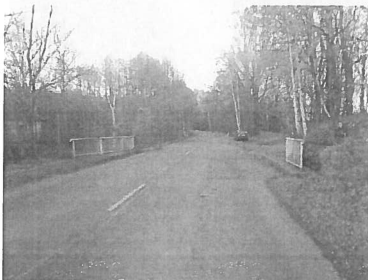
Pohled po směru staničení.
