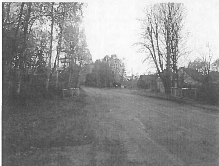
Pohled proti směru staničení.
