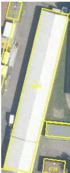
Objekt materiálně technického zabezpečení – 5
