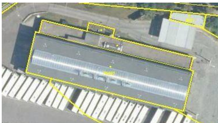
Hala povrchových úprav – 3
