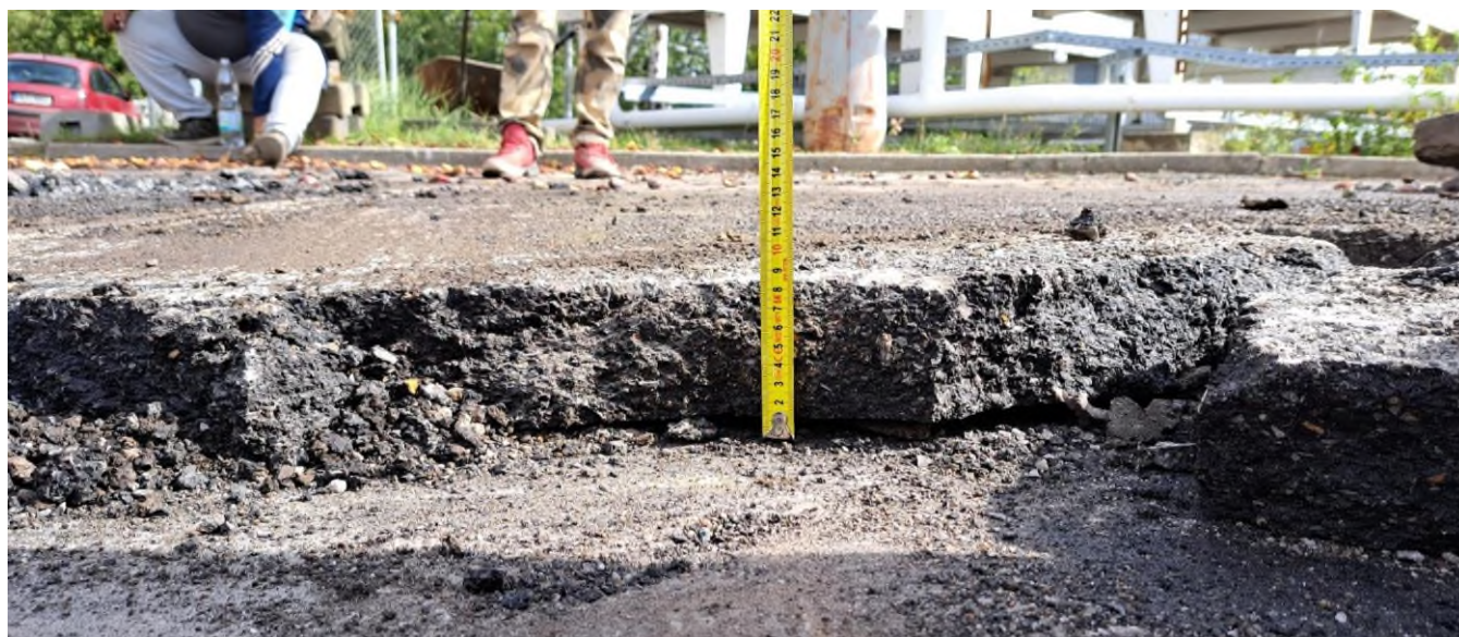
Obr. 2 – první vrstva živičného krytu v tl. 90 mm (foto ze dne 5. 10. 2022)
