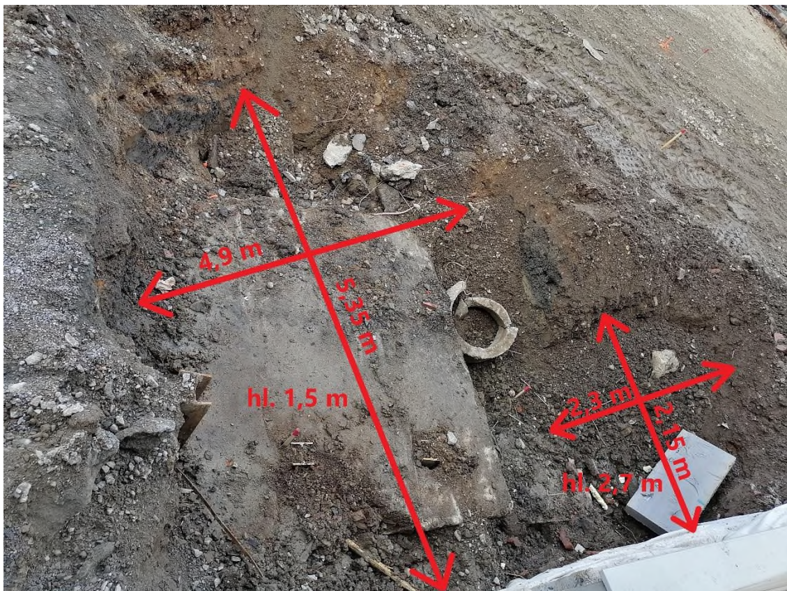
Obr. 6 – obnažené ŽB panely, které zůstanou ponechány (foto ze dne 25. 10. 2022)
