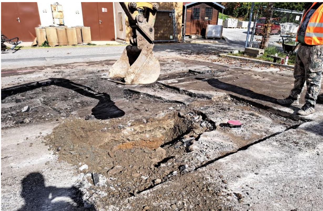
Obr. 1 – Provádění bouracích prací (foto ze dne 5. 10. 2022)
