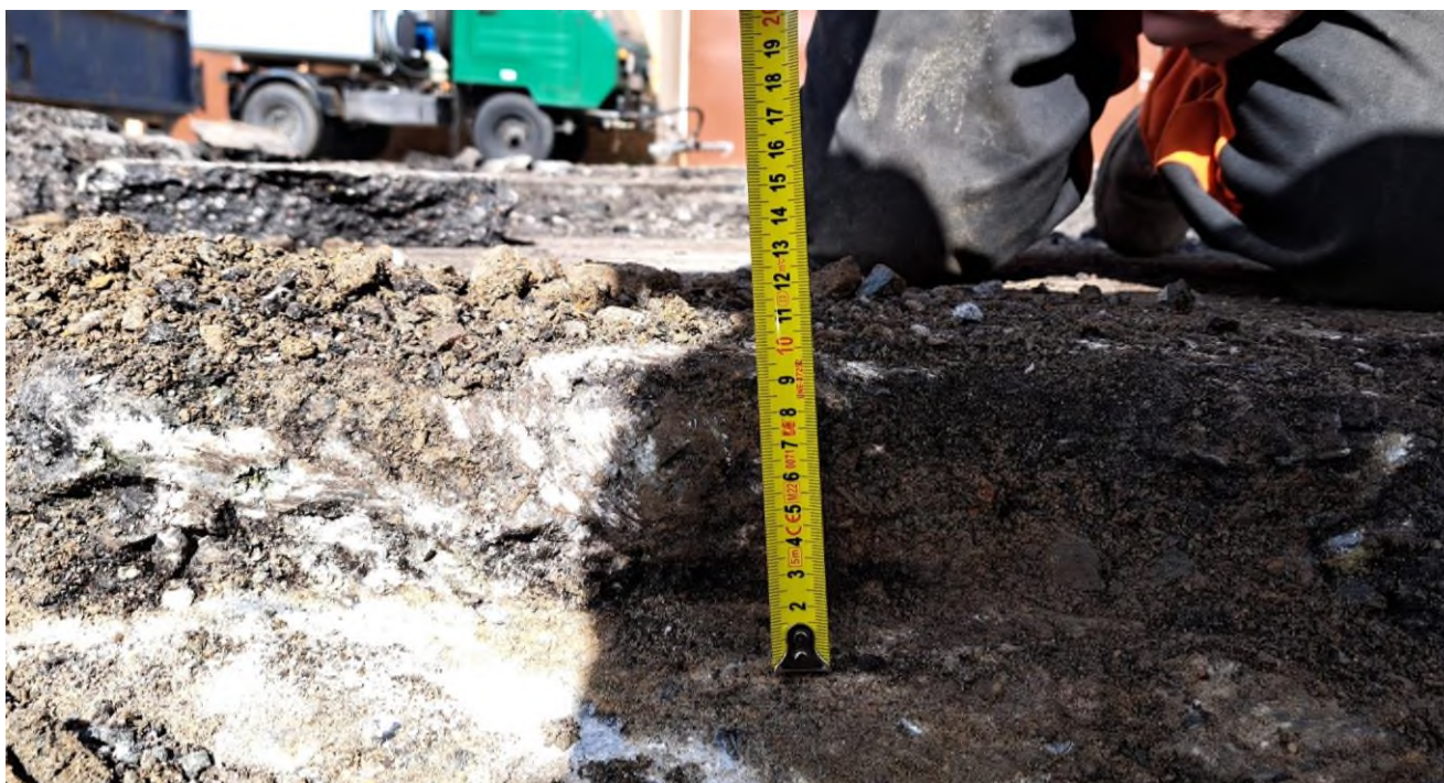
Obr. 4 – třetí vrstva živičného krytu v tl. 100 mm (foto ze dne 5. 10. 2022)
