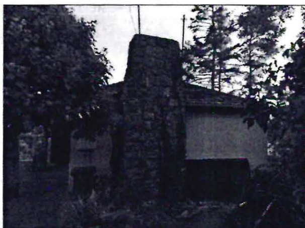
Rekreační objekt na parc. č. 3247
