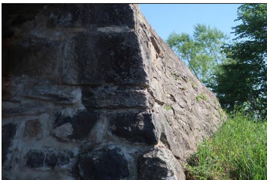
levé křídlo O1
