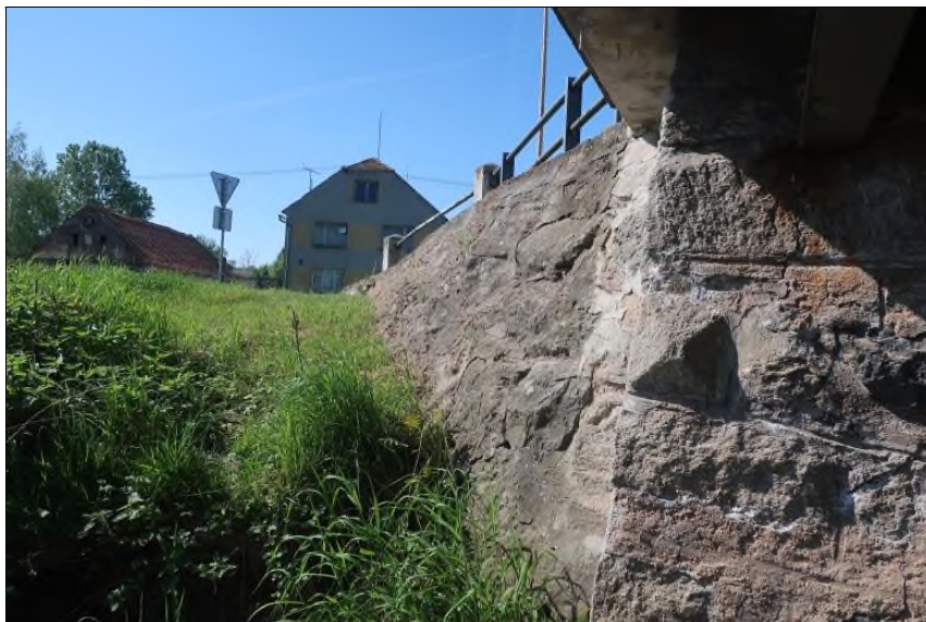
levé křídlo O4
