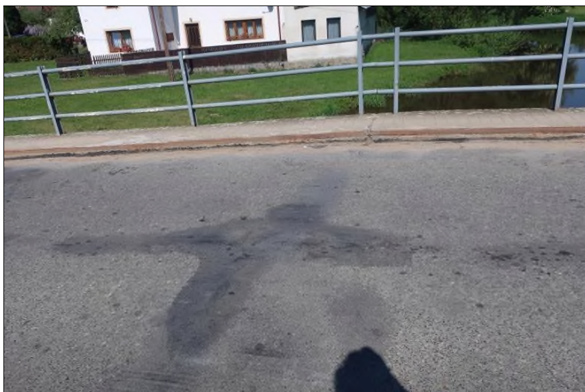
opravy krytu vozovky
