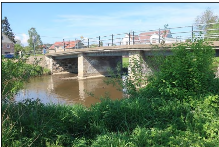
pohled na most
