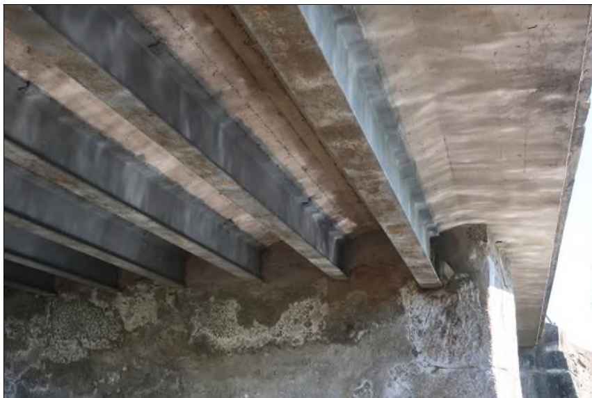
pohled na uložení 2. pole do P2
