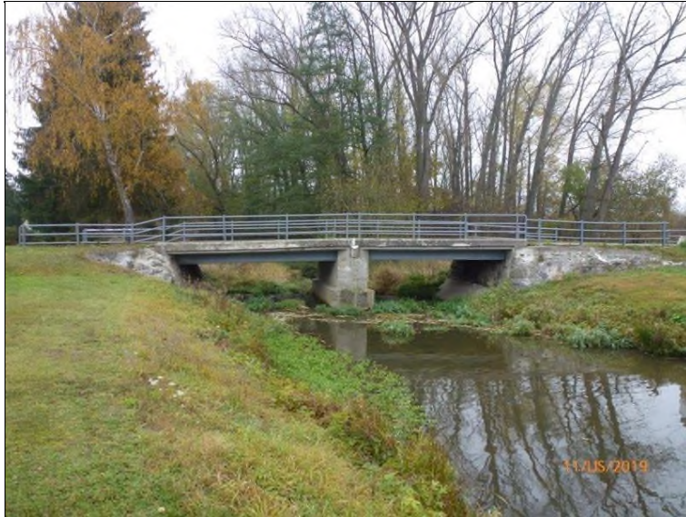
Pohled na pravou (návodní) stranu mostu.
