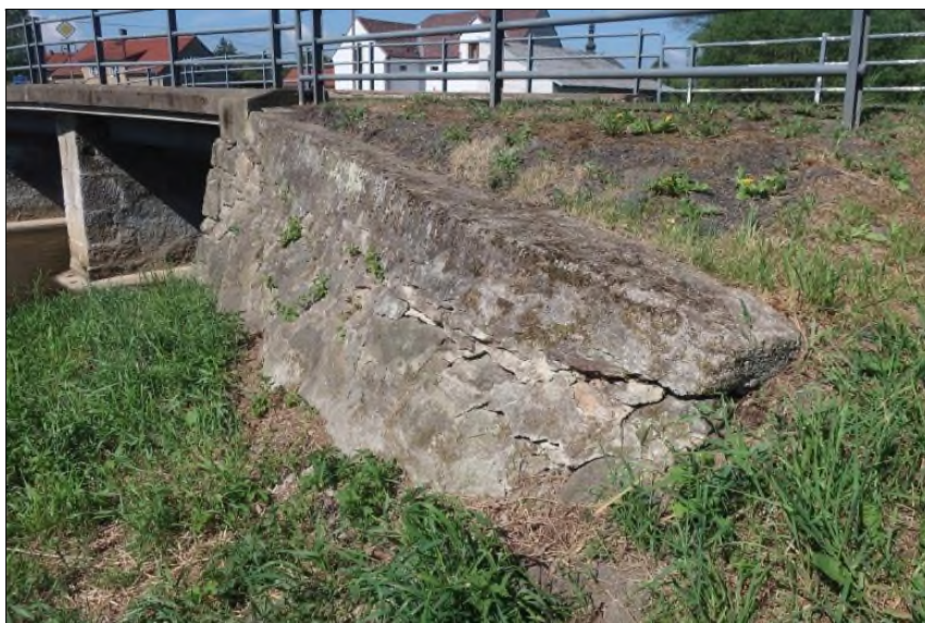
levé křídlo O1
