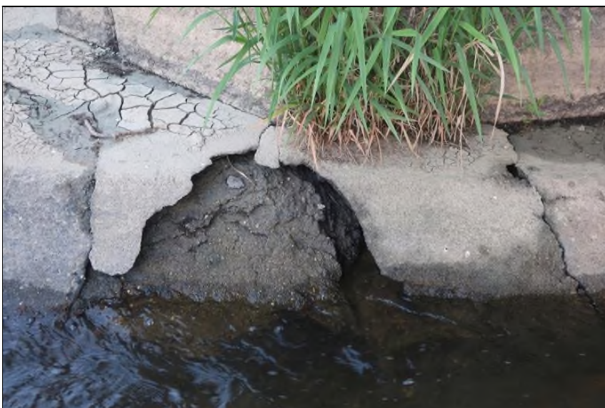
podemleté zpevnění zdiva dříku P2 v úrovni kolísání běžné hladiny Radbuzy
