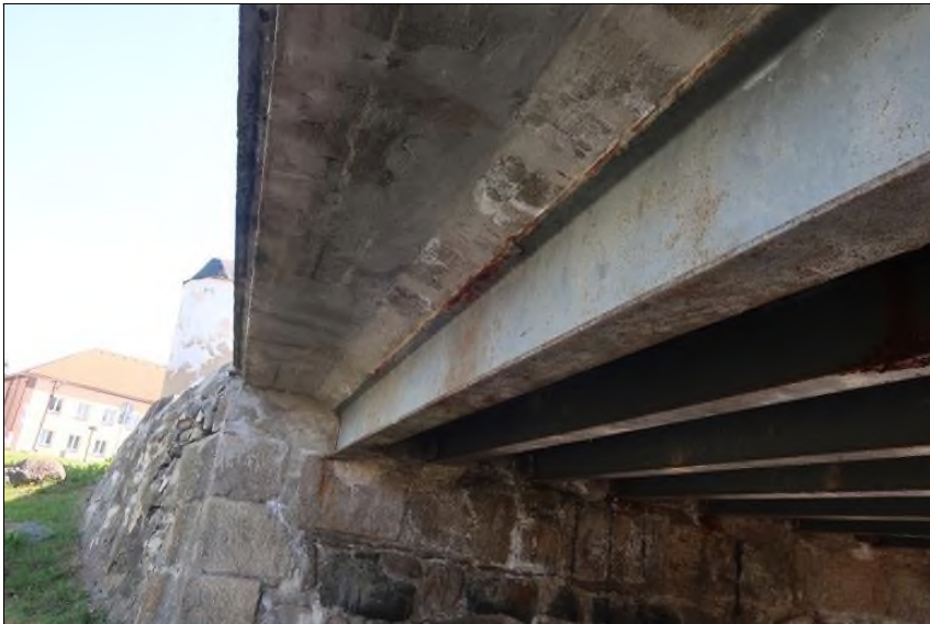
podhled pravé konzoly v 1. poli
