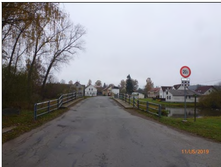
Pohled na most ve směru staničení.
