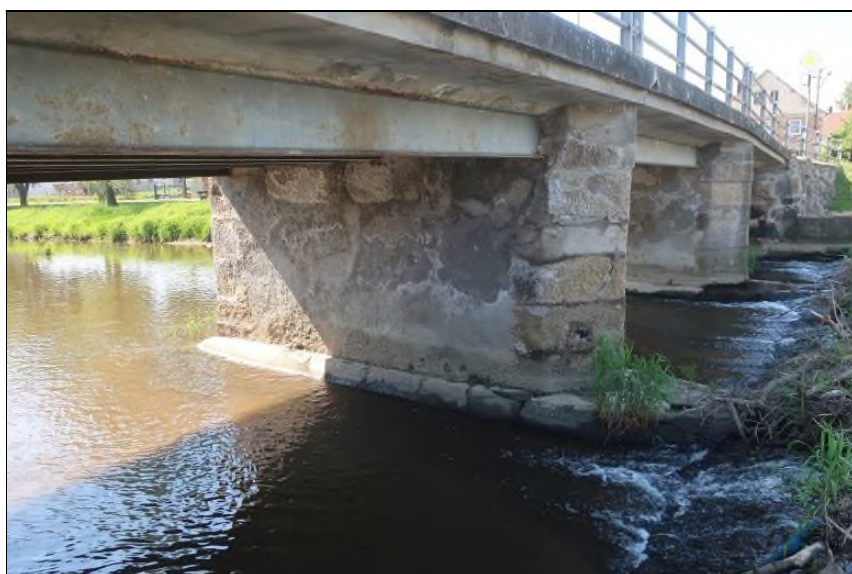
pravý bok mostu od O1
