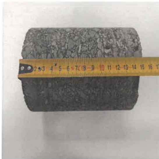
Jádrový vývrt č. 7
