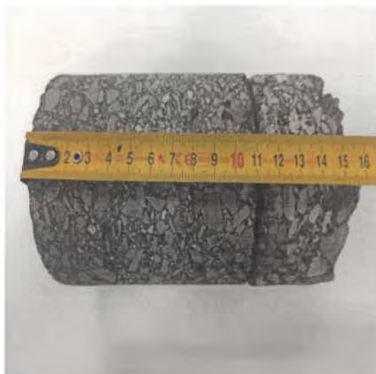
Jádrový vývrt č. 10
