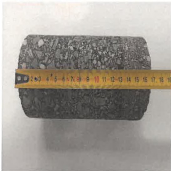
Jádrový vývrt č. 4
