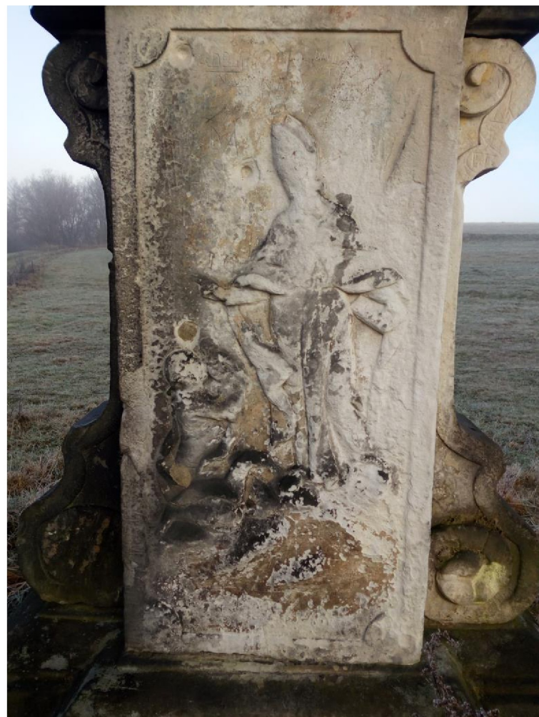
Poškozený podstavec, povrch kamene na reliéfu je korodovaný, zvětralý.
