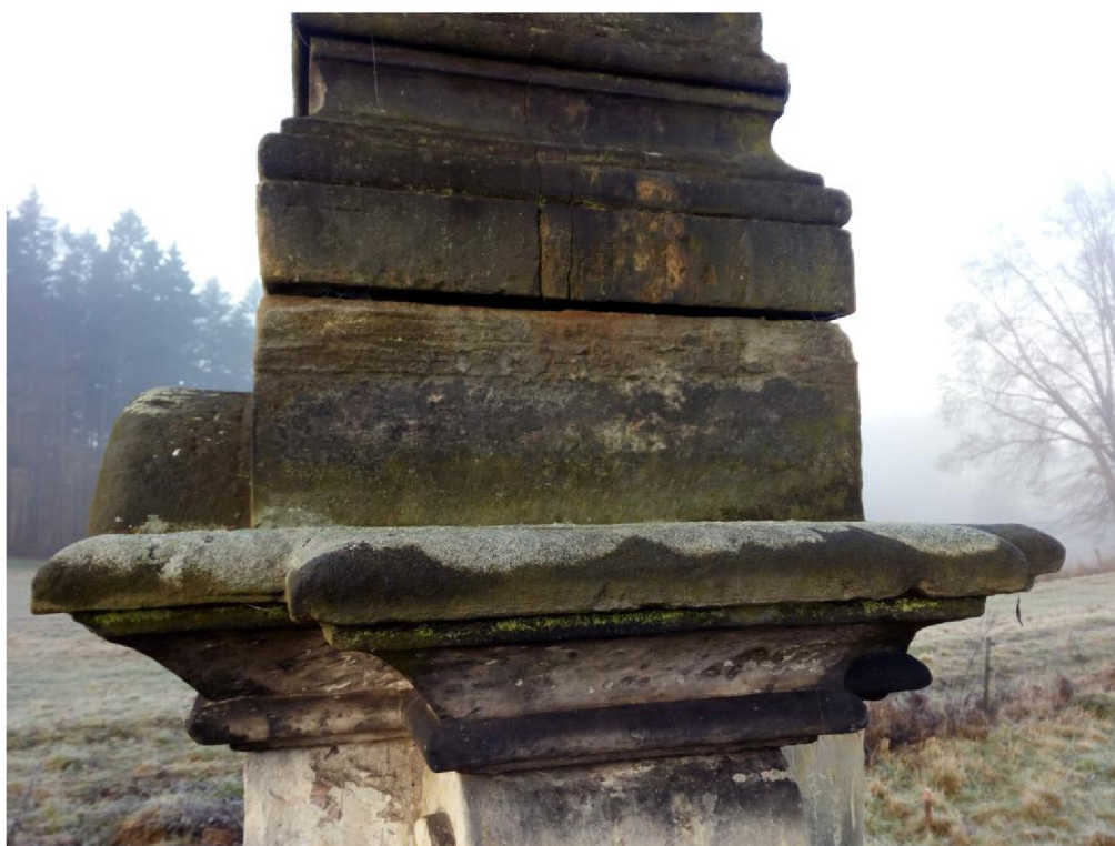
Římsa poškozená tmavými depozity, výkvěty solí a prasklinou vlivem korodujícího čepu s četnými tmavými depozity a krustami.
