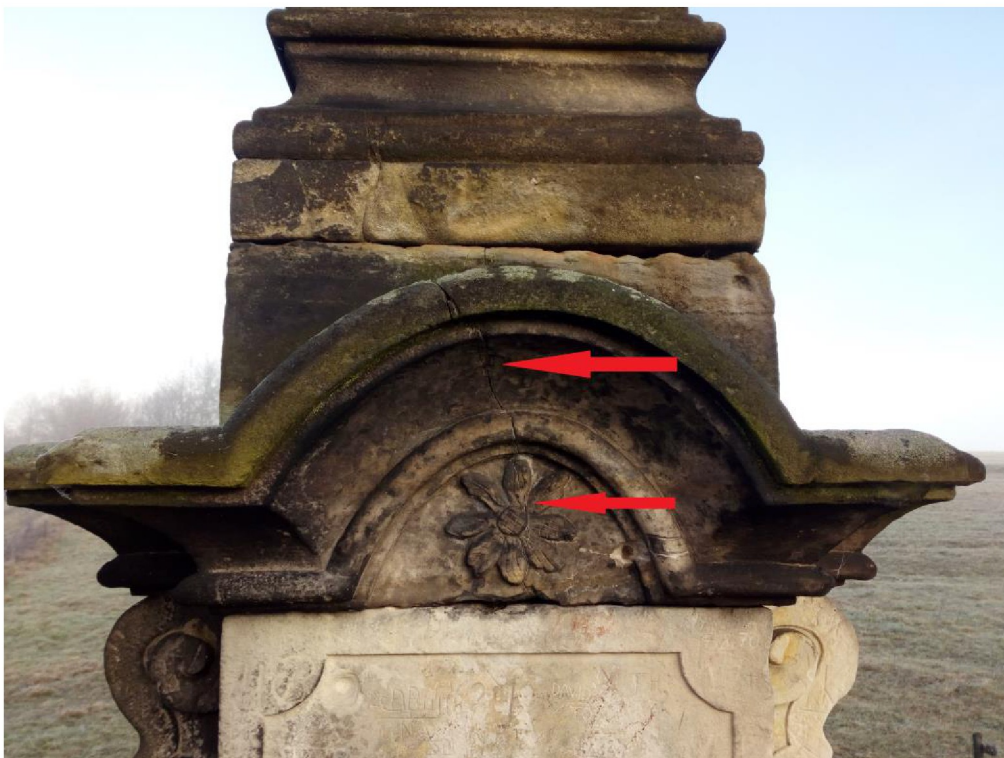
Římsa poškozená tmavými depozity, výkvěty solí a prasklinou vlivem korodujícího čepu.
