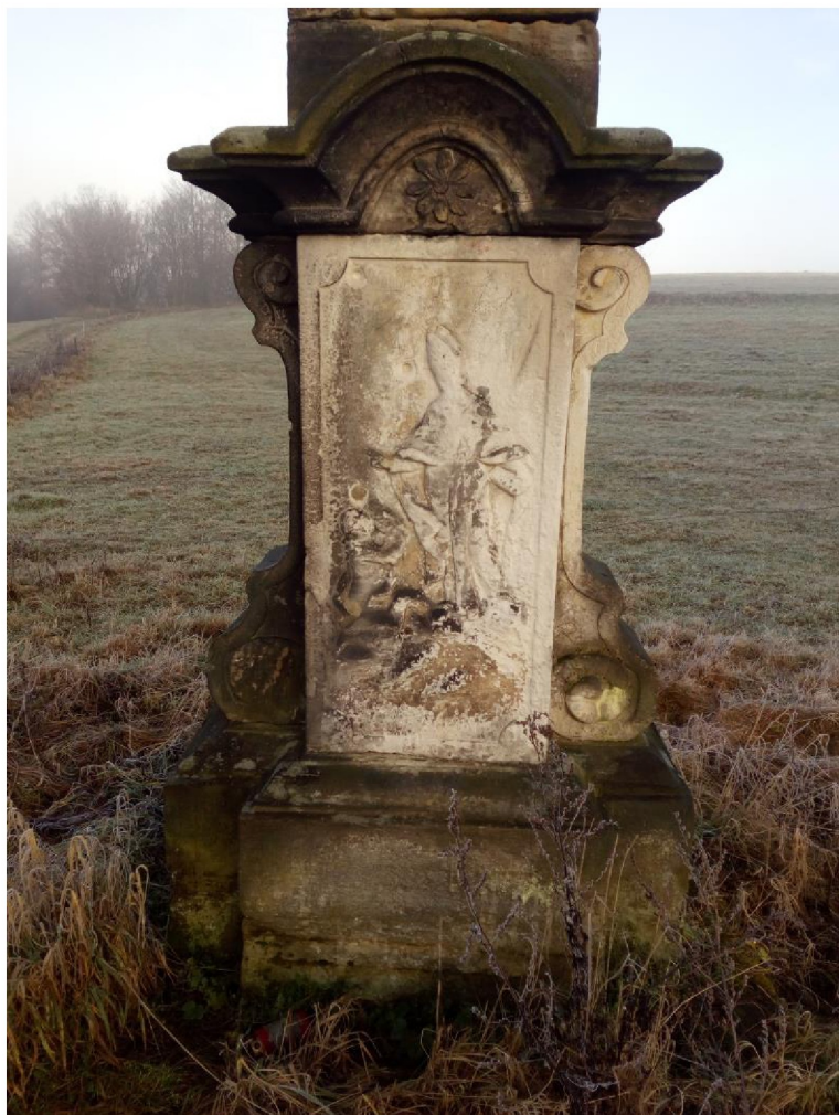
Poškozený podstavec, povrch kamene na reliéfu je korodovaný, zvětralý.
