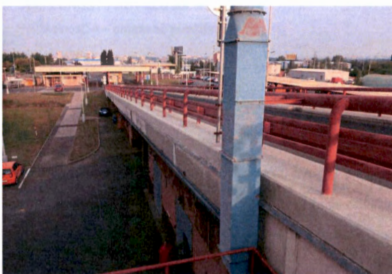
pohled na levý bok nájezdové rampy ve směru zvoleného staničení
