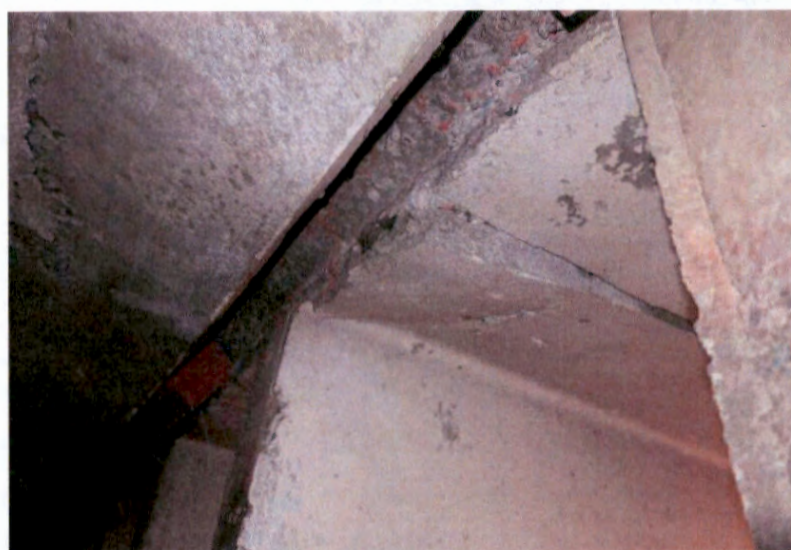
podhled nosné konstrukce plošiny v oblasti horního MZ
