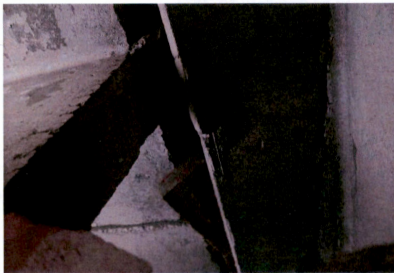
podhled nosné konstrukce nájezdové rampy v oblasti spodního MZ
