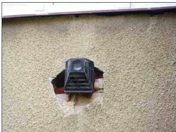
Nezačištěné okraje odvětrání podokenního hnízdiště rorýse obecného
