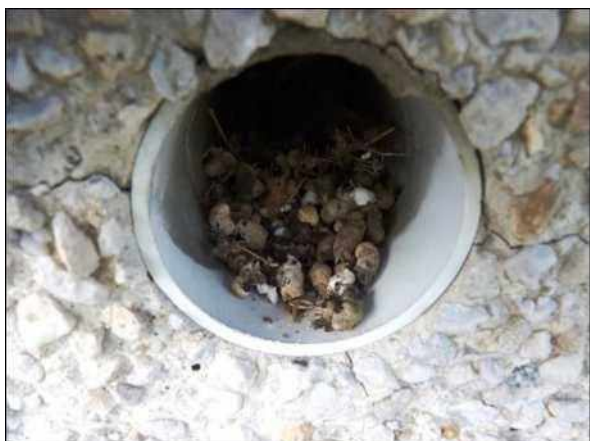
Trus rorýse obecného v ústí ventilačního otvoru
