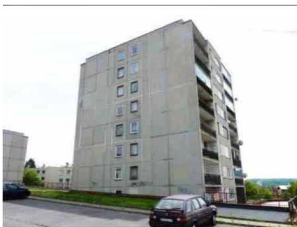
Panelový bytový dům
