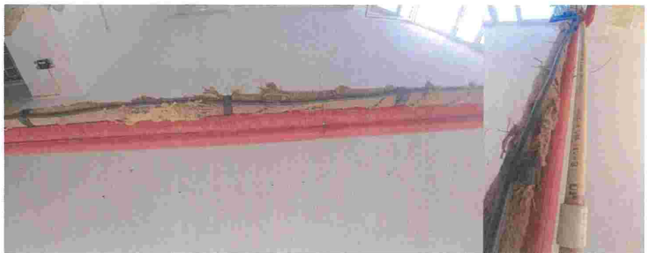
Staré rozvody v učebně dříve
