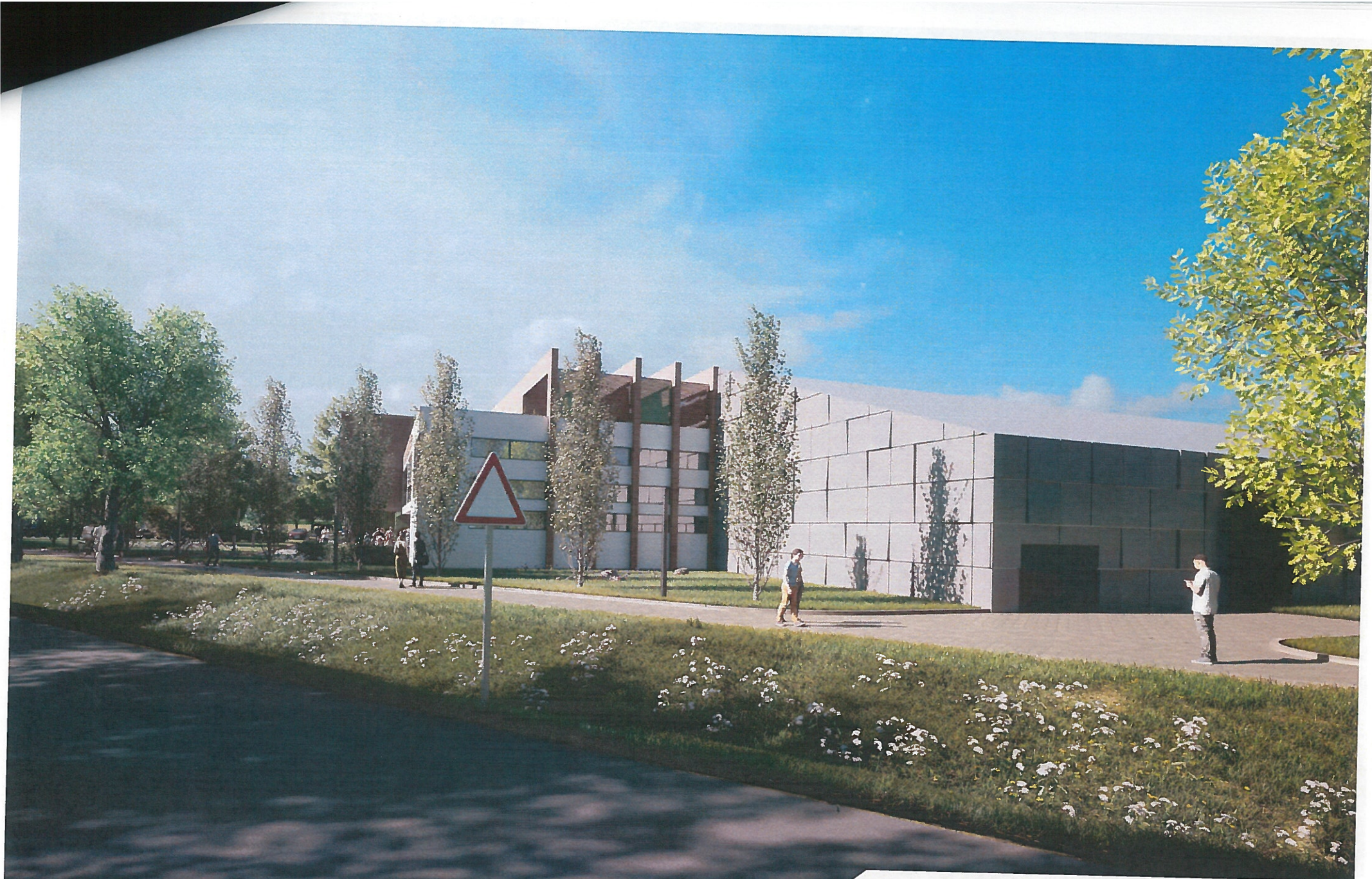
POHLED Z KOMUNIKACE
