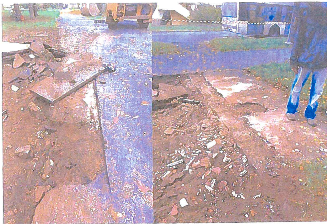
Podbetonované živice chodníků
