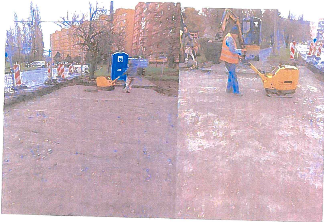
Sanace podkladu – hutnění
