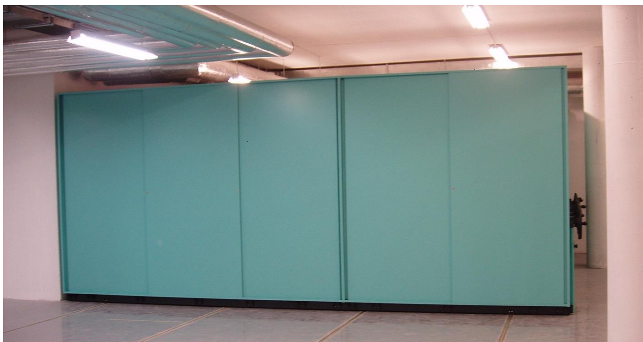
Posuvné dveře na boční stranu regálového systému
