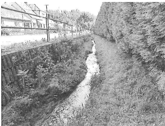
Petrůvka, střední úsek, stávající vyústní objekt
