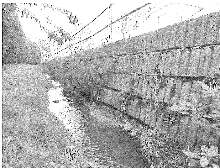
Petrůvka, střední úsek, vyklápějící se porušená OZ
