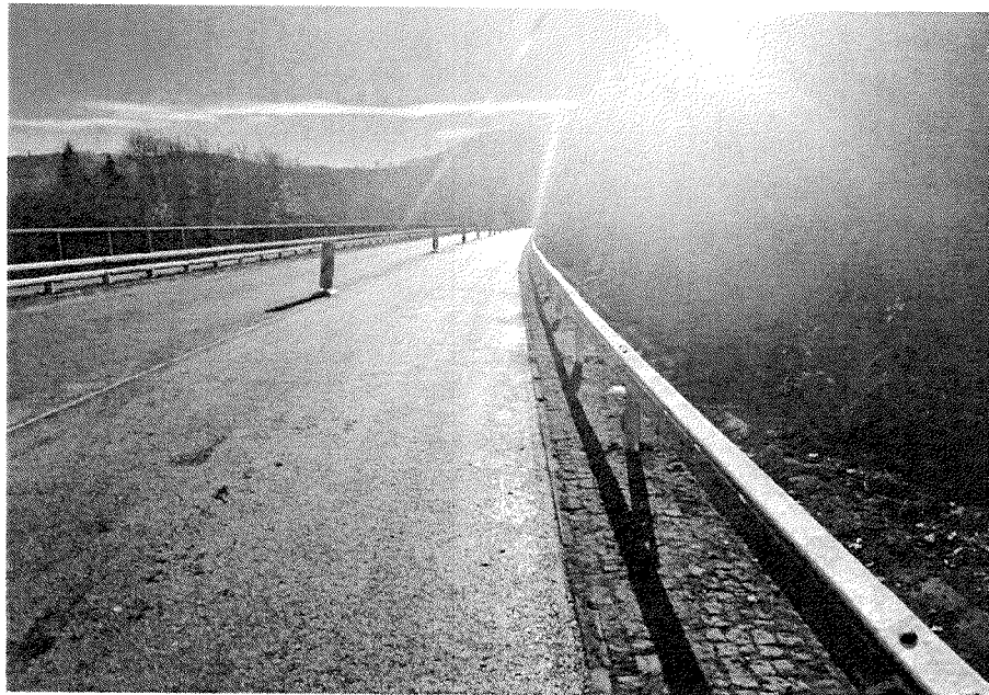
STAV PO OPRAVĚ KM 13,190
