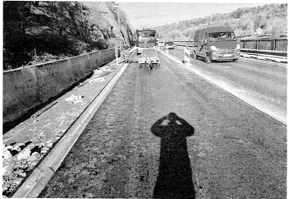
MONTÁŽ OCELOVÉHO SVODIDLA - VPRAVO KM 13,470
