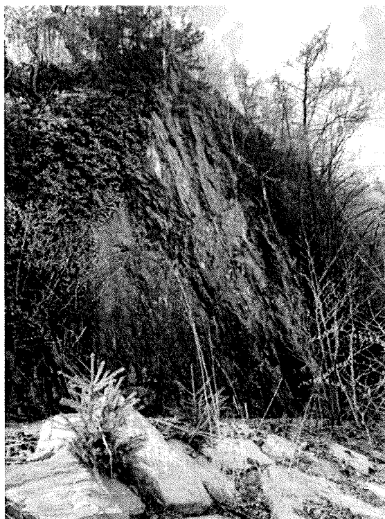
Obrázek 4: Celkový pohled na stěnu
