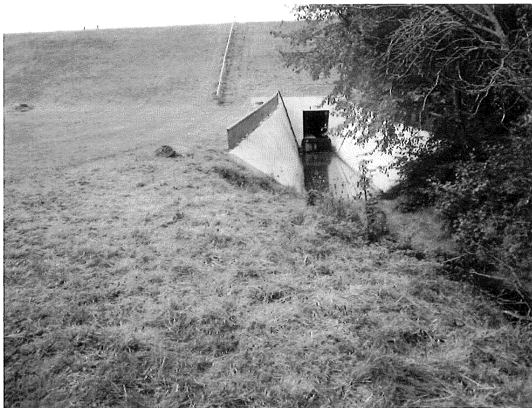
Obr. č. 3: Pohled na vývar a navazující odpadní koryto
