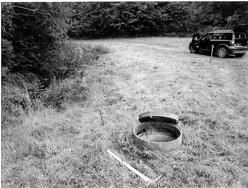
Obr. č. 2: Pohled na šachtu KŠ6, do které bude zaústěn nový drén
