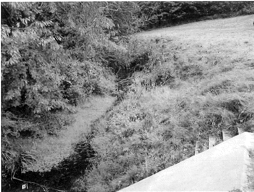
Obr. č. 1: Pohled na odpadní koryto VD - ujíždění pravého svahu
