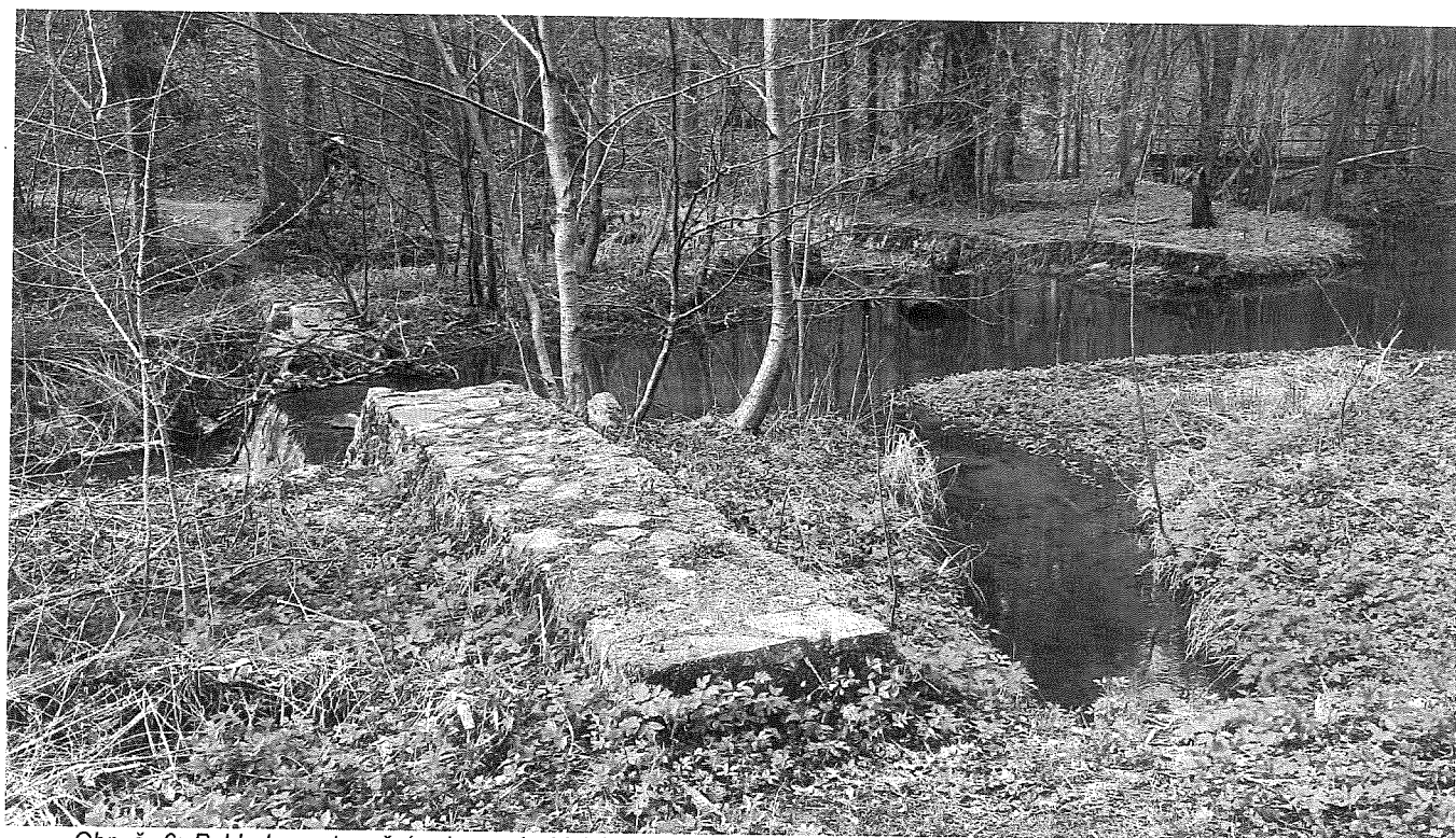
Obr. č. 6: Pohled na stupeň (vzdouvací objekt) z roku 2008 na vodním toku Říčka, vpravo nátokový kanál do náпустného objektu. V pozadí původní vzdouvací objekt, nyní tvořící jakýsi bajpás
