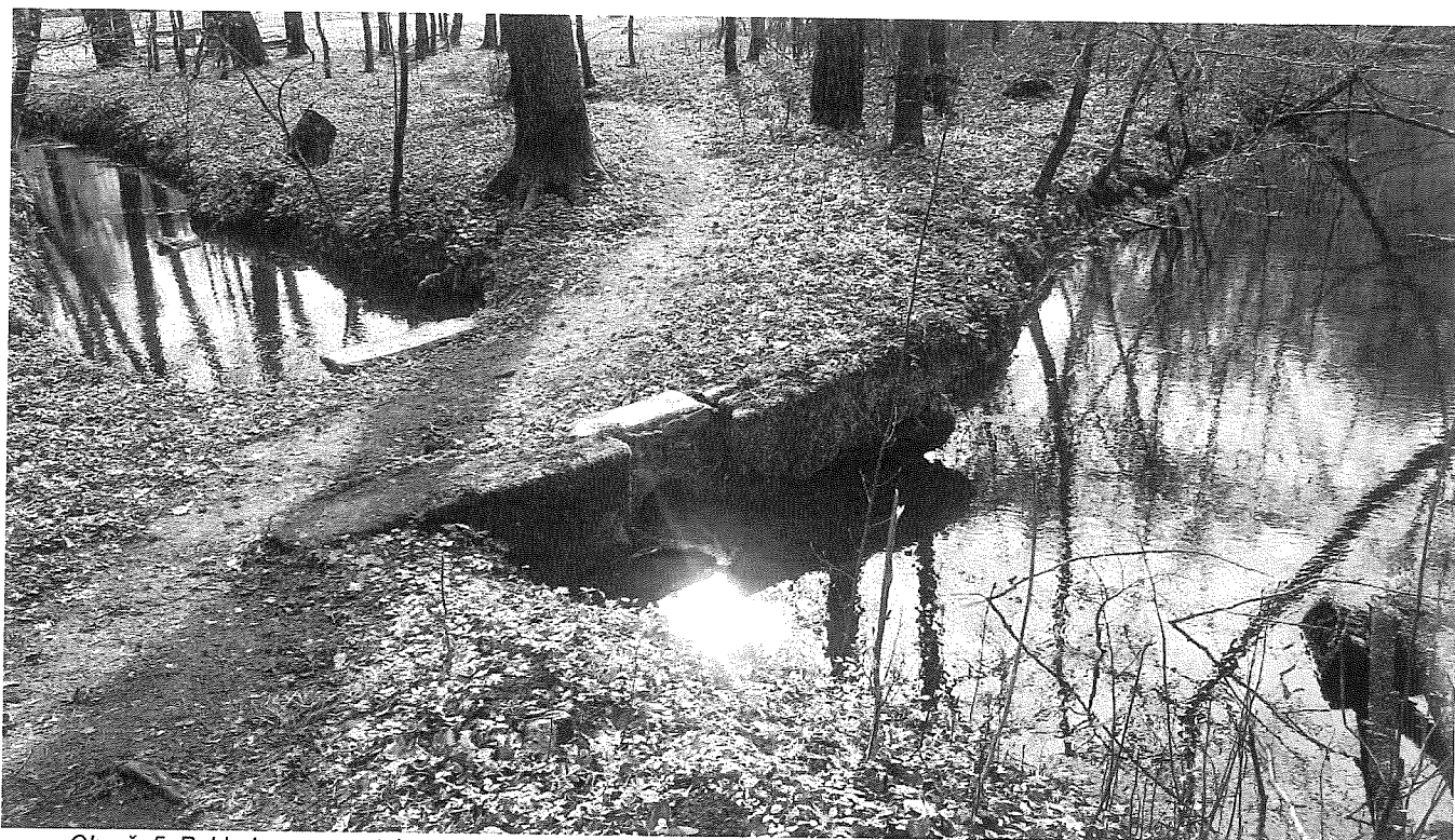
Obr. č. 5: Pohled na propustek na propojovacím kanále mezi horní a dolní nádrží
