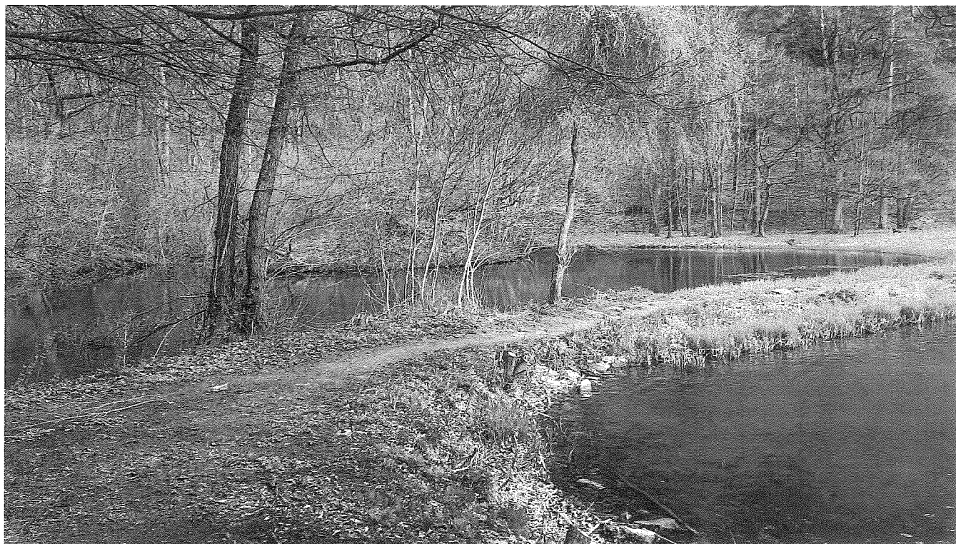
Obr. č. 3: Pohled na hráz oddělující horní a dolní nádrž
