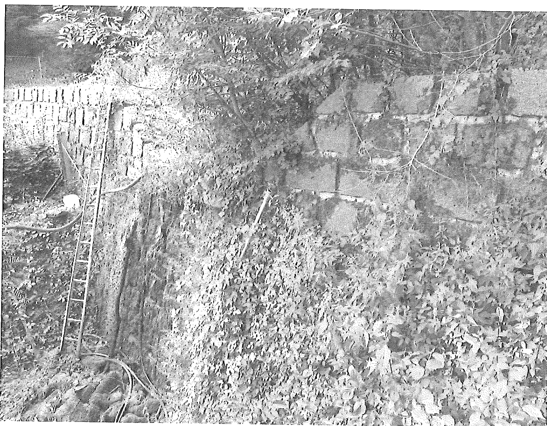
Přehrážka na konci úseku
