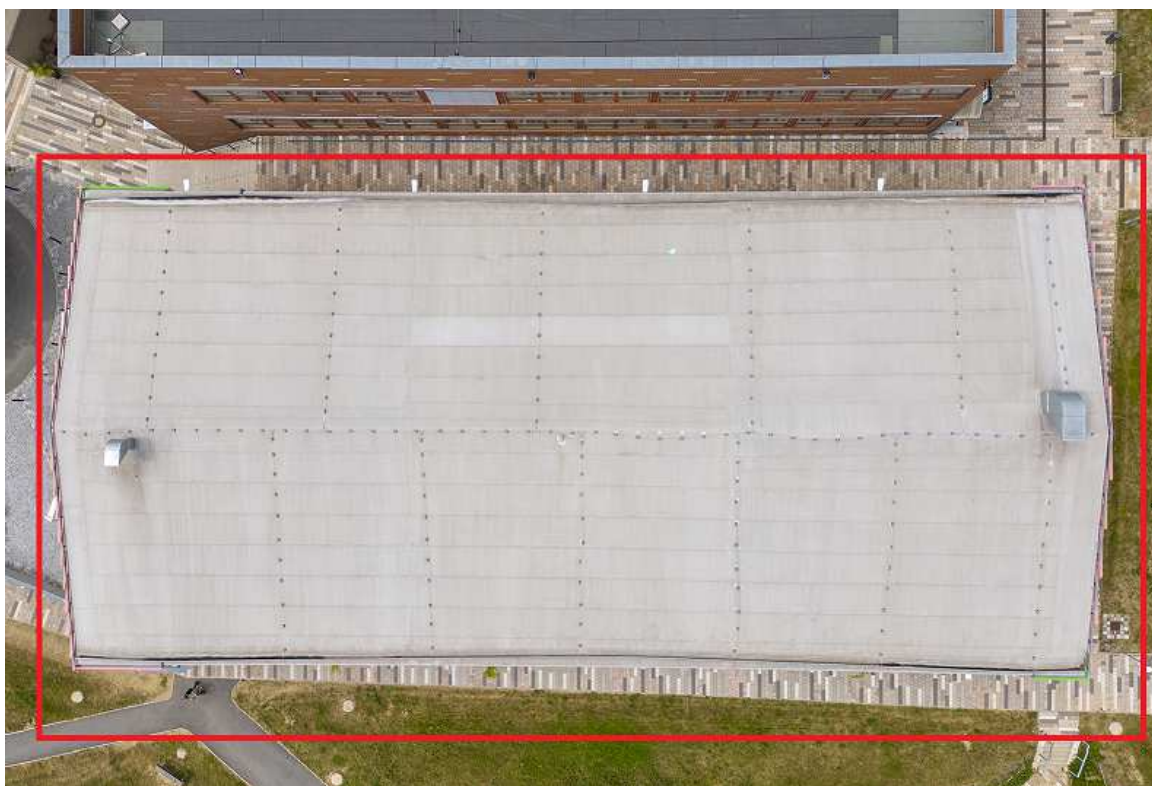
obr.č. 4 – pohled na střešní konstrukci sportovní haly
