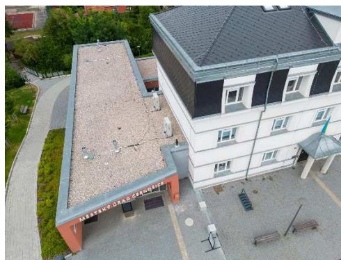
Plochá střecha budovy pošty
