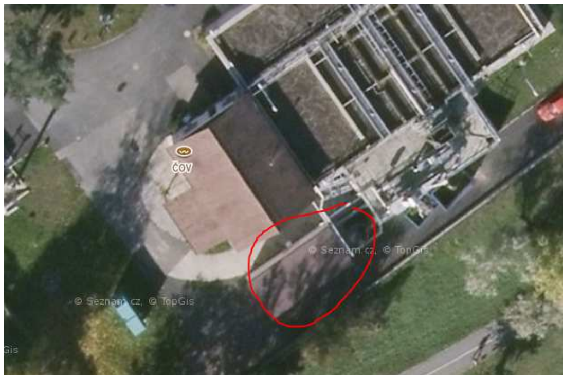
obr.č. 6 – pohled na střešní konstrukci dmychárny ČOV
