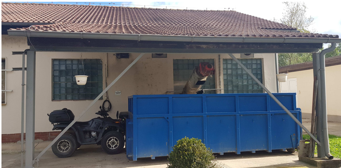
obr.č. 2 – pohled na podpůrnou konstrukci přístavku provozní budovy ČOV
