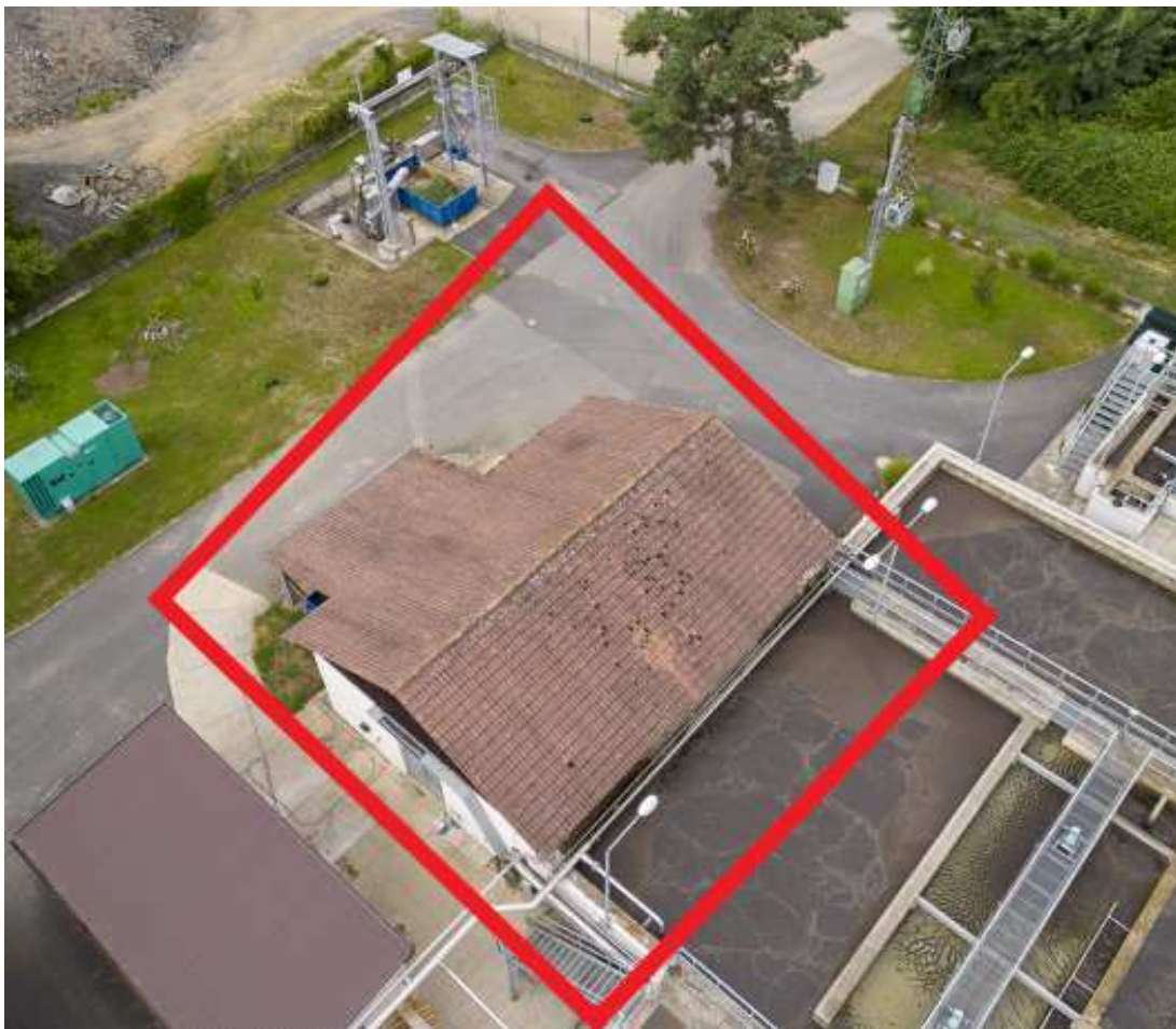
obr.č. 5 – pohled na střešní konstrukci provozní budovy ČOV
