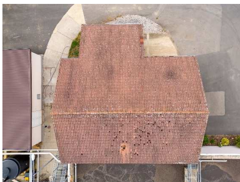
Střecha provozní budovy
