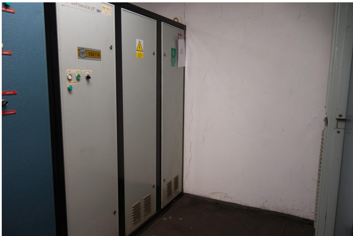
rozměry rozvaděče: 180 x 60 x 200 cm (d x š x v)
