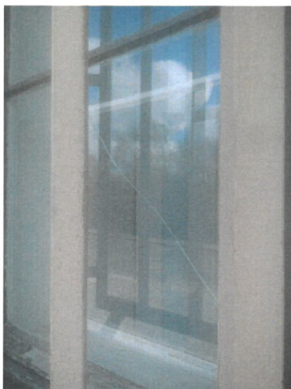
Obrázek 4: Popraskané sklo
