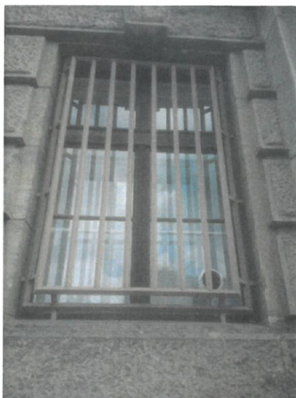
Obrázek 3: Okno s otvorem pro klimatizaci
