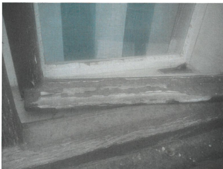
Obrázek 1: Odlupující se barva na spodních okapnicích
