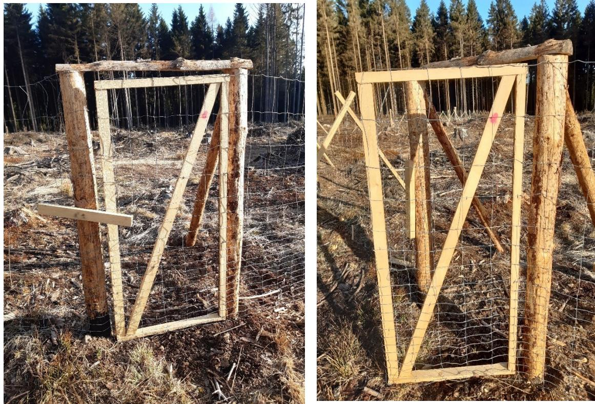
Pletivo přibité na dřevěný rám (lať, přířezy, krajinky). Zajištění proti samovolnému otevření z venkovní strany pomocí dřevěného kolíku umístěném ve středu kůlu (sloupu) prostřednictvím hřebíku (vrutu). Samovolné otevření do prostoru oplocenky je zajištěno zarážkou (kolíkem) o průměru min. 7 cm a délce min. 50 cm, jež je zatlučen v rostlé zemi min. 40 cm.
