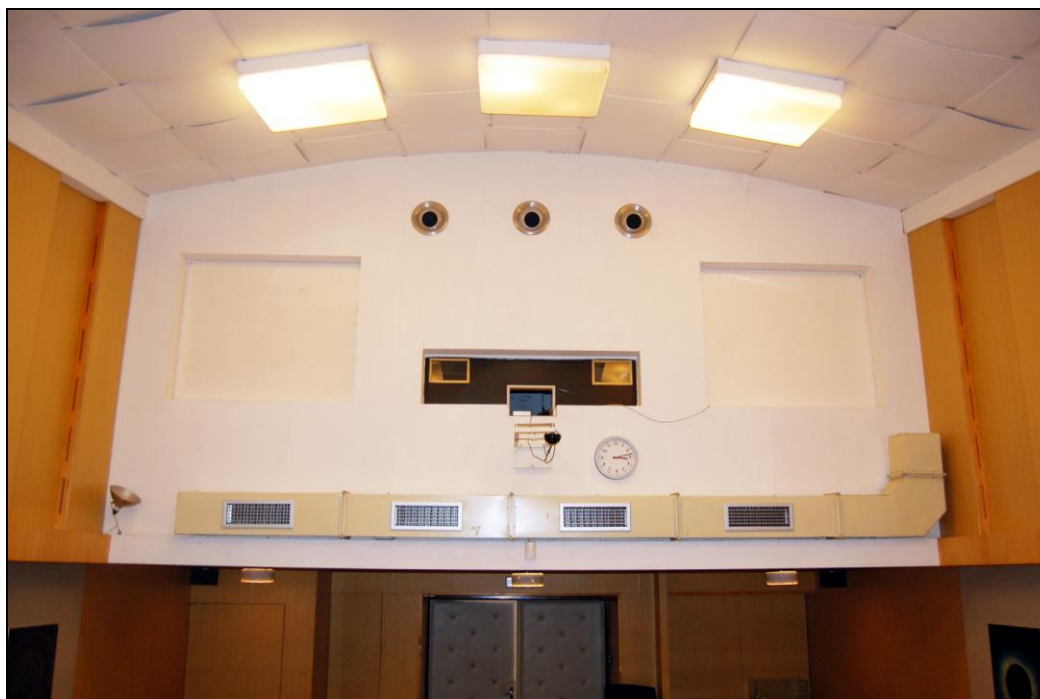
Obrázek 02 – stávající stav zadní stěny přednáškového sálu. Cílem rekonstrukce je zakrýt nevzhledné rozvody vzduchotechniky až do výše otvorů. Symetrické otvory vybavit speciálními skly v subtilních Al rámech, polovina šířky posuvné okno. Skla budou polepena fóliemi proti pronikání světla do přednáškového sálu. Na stěně bude také umístěno speciální osvětlení.
