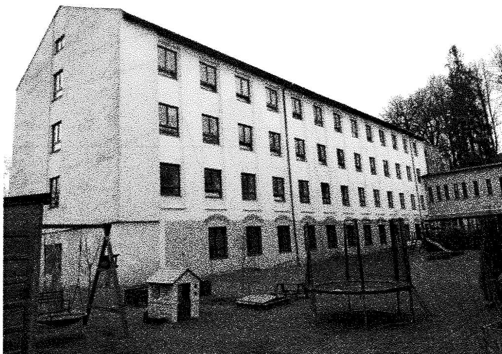
Obrázek 3: Pohled na budovu označenou „DM“
