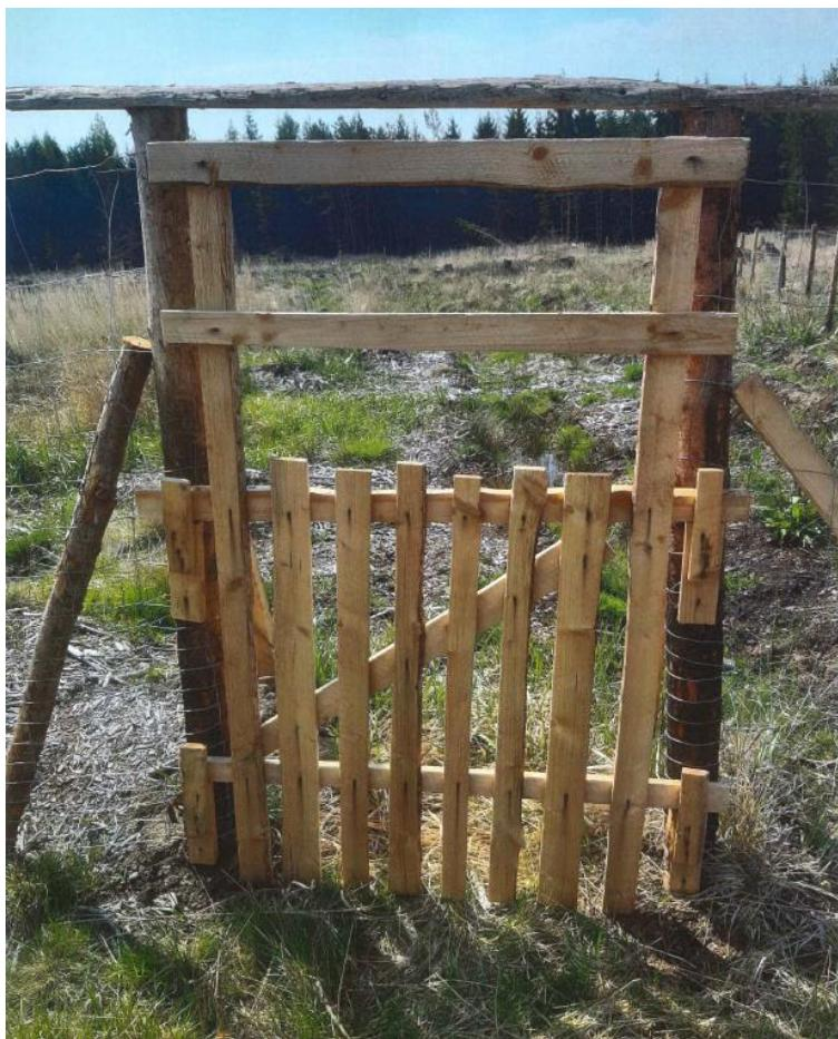
Dřevěná branka z latí (ráhen) výšky 160 cm. Podélně umístění prvků (vztaženo k zemi) ve výšce cca 30, 100, 130 a 160 cm. Svislé prvky maximální mezera 5 cm. Zpevnění příčnou latí (ráhnem) mezi cca 30 a 100 cm od země. Uchycení pomocí čtyř zahnutých hřebíků případně dřevěných zámeků (viz obr. výše) přichycených hřebíky (případně vruty – ocelové sloupky).
