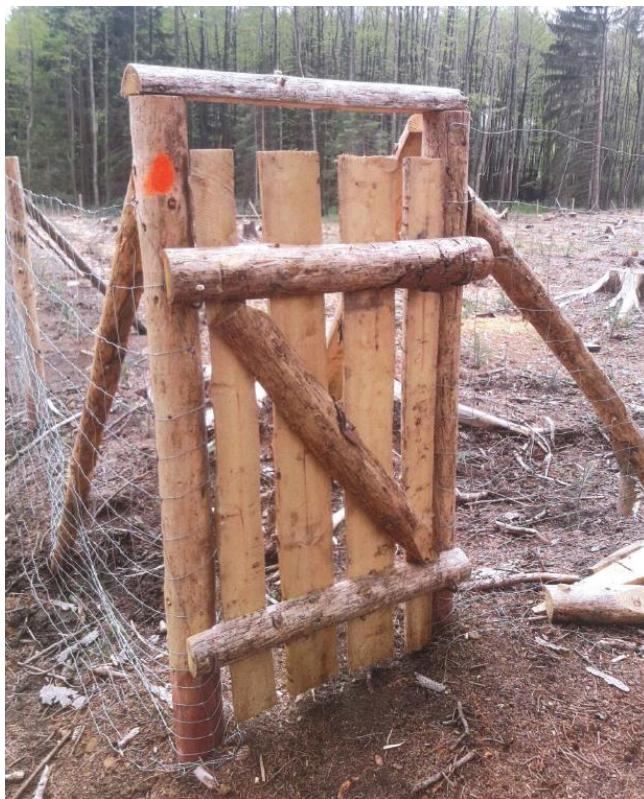
Dřevěná branka z latí (ráhen) výšky 160 cm. Podélně umístění prvků (vztaženo k zemi) ve výšce cca 30 a 140 cm. Svislé prvky maximální mezera 5 cm. Zpevnění příčnou latí (ráhnem) mezi cca 30 a 140 cm od země. Uchycení pomocí čtyř zahnutých hřebíků.
