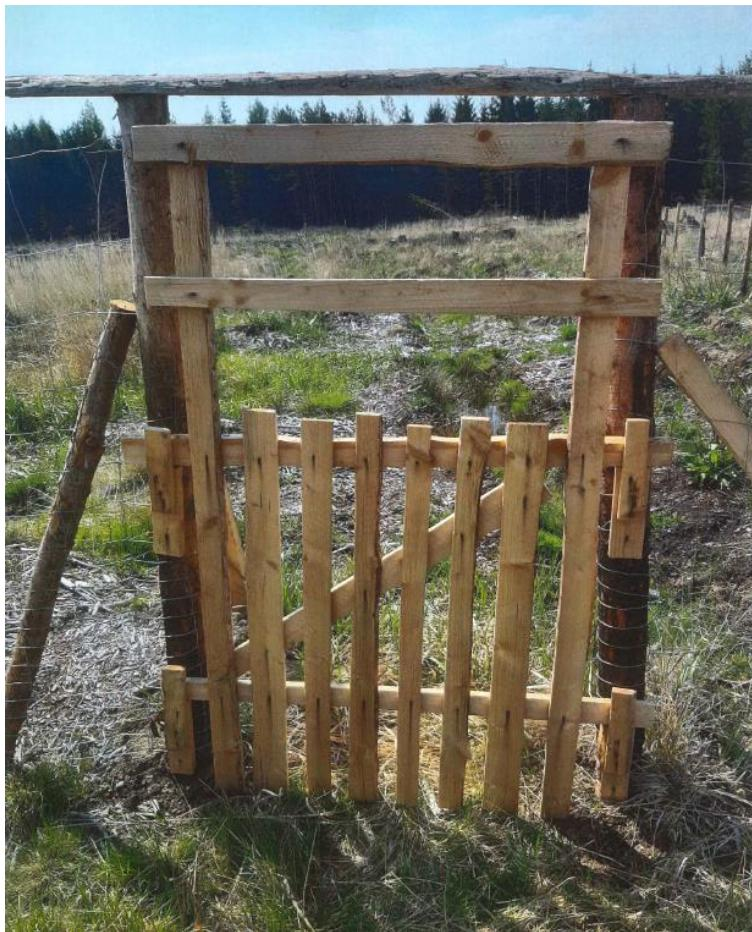
Dřevěná branka z latí (ráhen) výšky 160 cm. Podélně umístění prvků (vztaženo k zemi) ve výšce cca 30, 100, 130 a 160 cm. Svislé prvky maximální mezera 5 cm. Zpevnění příčnou latí (ráhnem) mezi cca 30 a 100 cm od země. Uchycení pomocí čtyř zahnutých hřebíků případně dřevěných zámků (viz obr. výše) přichycených hřebíky (případně vruty – ocelové sloupky).
