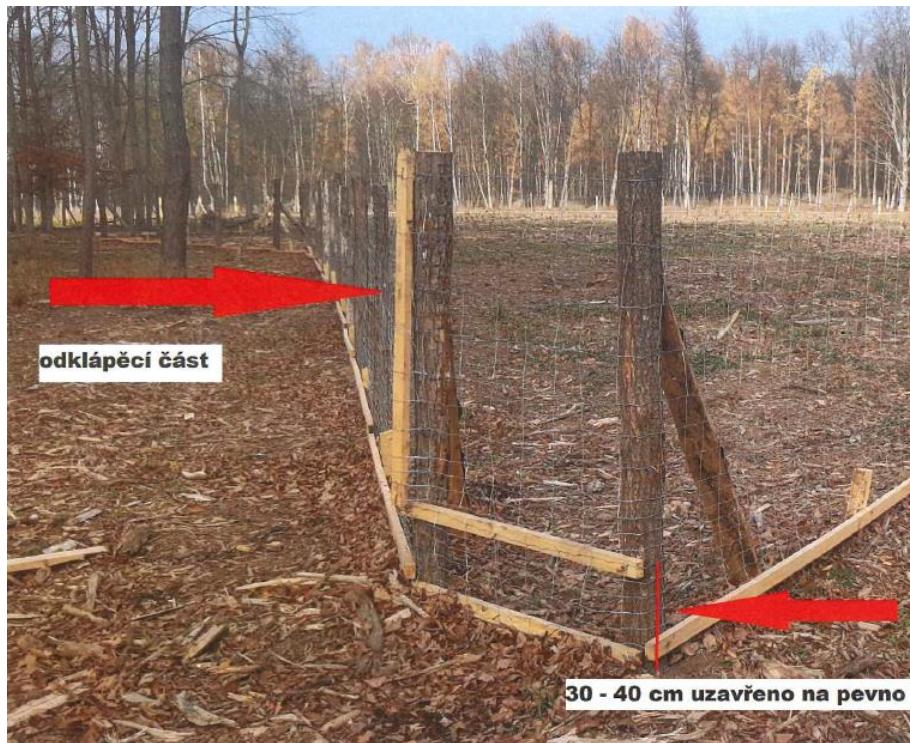
Konec pletiva bude přibitý na lati (kuláček, pulsuláček), jež poslouží k otevírání branky. Odklápací část bude zajištěna proti samovolnému otevření pomocí dvou zahnutých hřebíků umístěných ve spodní a horní části nosného kůlu. Spodní část branky 30-40 cm od země uzavřena na pevno – 2x lať (ráhno).
