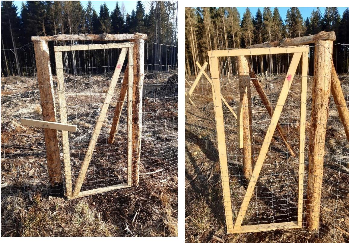
Pletivo přibité na dřevěný rám (lať, přířezy, krajinky). Zajištění proti samovolnému otevření z venkovní strany pomocí dřevěného kolíku umístěném ve středu kůlu (sloupku) prostřednictvím hřebíku (vrutu). Samovolné otevření do prostoru oplocenky je zajištěno zarážkou (kolíkem) o průměru min. 7 cm a délce min. 50 cm, jež je zatlučen v rostlé zemi min. 40 cm.
